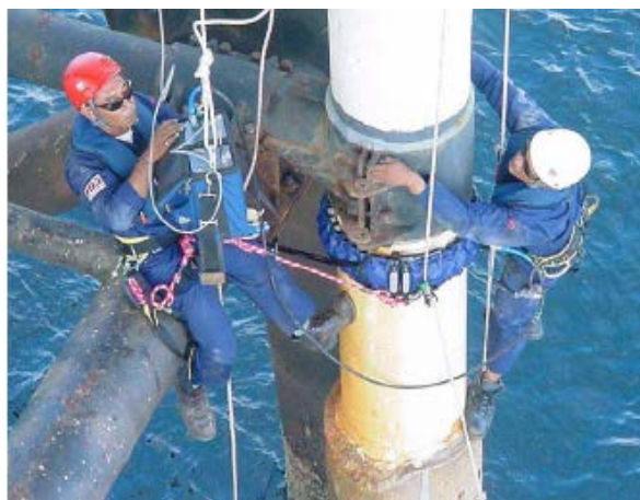
13. ábra. LRUT alkalmazások: gázvezeték és offshore szerkezet.
