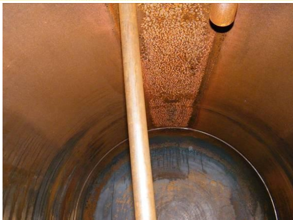
2. ábra – Egy tartály belseje. Az általános korrózió a folyadékszint feletti részeket érintette
