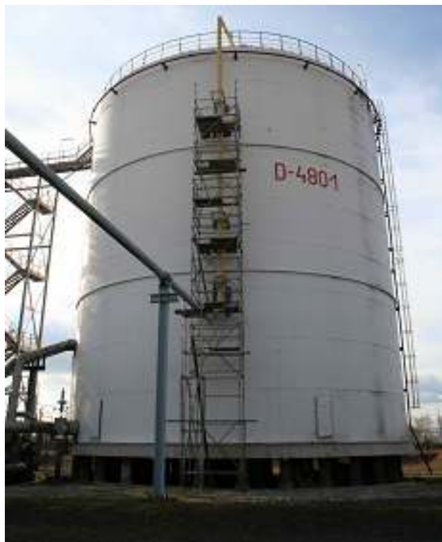
A tiszaujvárosi, 4724 m 3 -es, álló hengeres, kettős köpenyű tartály -104 °C-os folyékony etilén tárolásához
