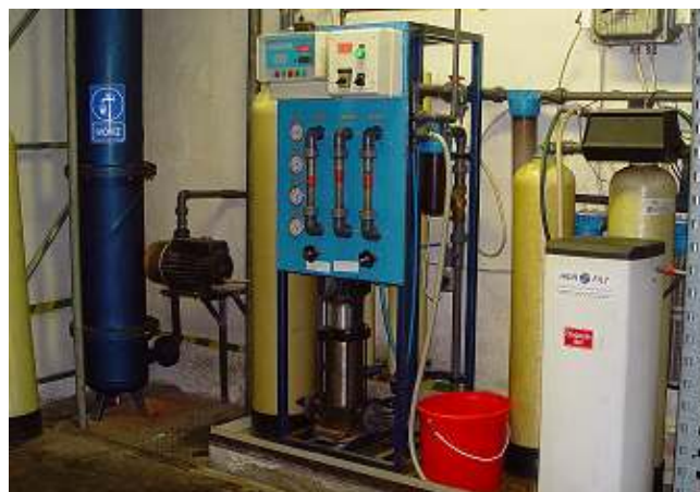
Kétlépcsős vízlágyító berendezés (RO + utólaggyító)
