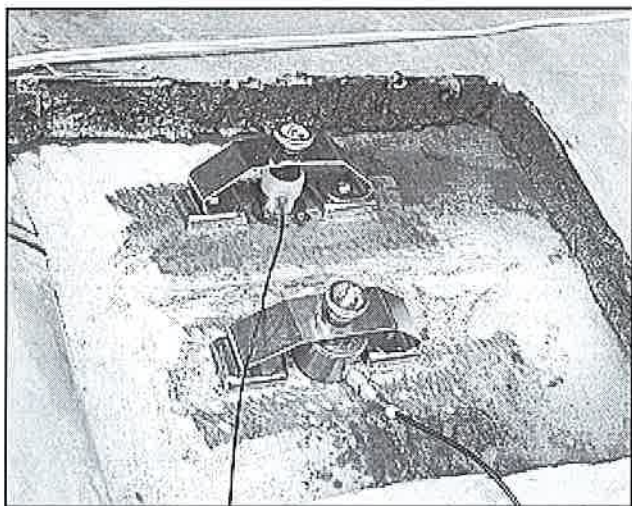
3. ábra. A két akusztikus emissziós mérőműszer egymás mellé telepített érzékelője
