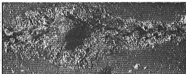
1. ábra. Pontkorrózió és a belőle kiinduló repedés. (IRIS-4 típusú készülékkel készült felvétel)
