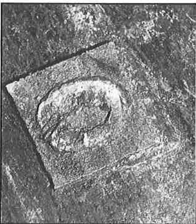
2. ábra Ráhegesztések a tartálypalást külső felületén
