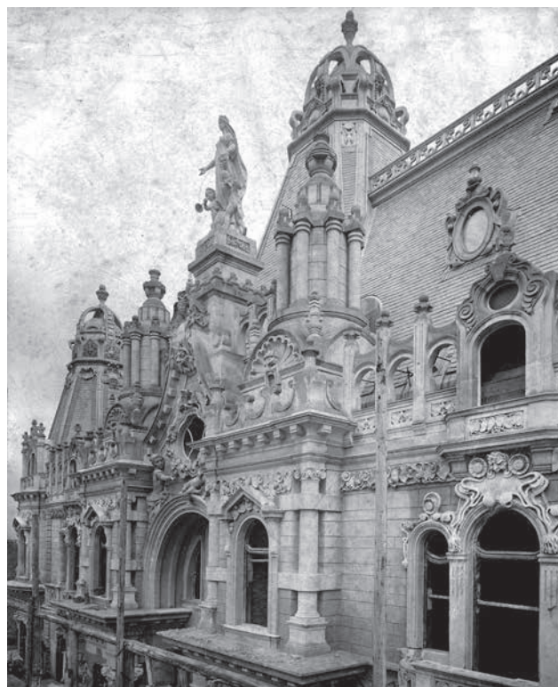
Az Osztálysorsjáték-palota építés közben, Budapest, 1899
