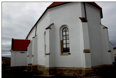
4. A templom jelenlegi összképe a felújítás után, délkeleti irányból
