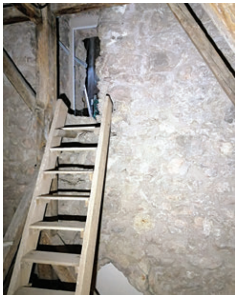
27. A középkori padlásbejárat a hajó padlója felől
