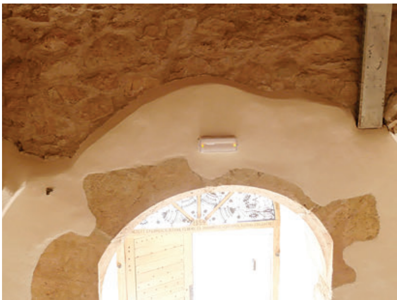
26. A toronyföldszint elbontott dongaboltozatának nyomai és az átjáró déli bejáratának belső kőkerete
