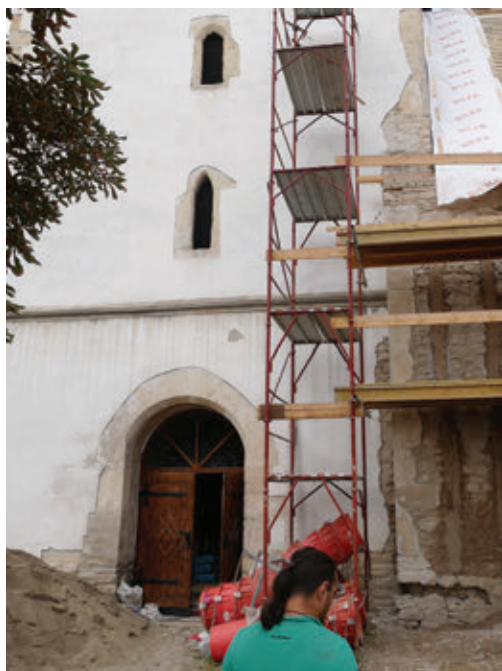
20. A torony déli homlokzata az átjáró bejáratával a helyreállítás idején
