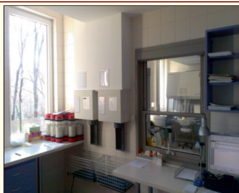
2. ábra: Az új labor citosztatikus fülkéi és csőposta állomása
