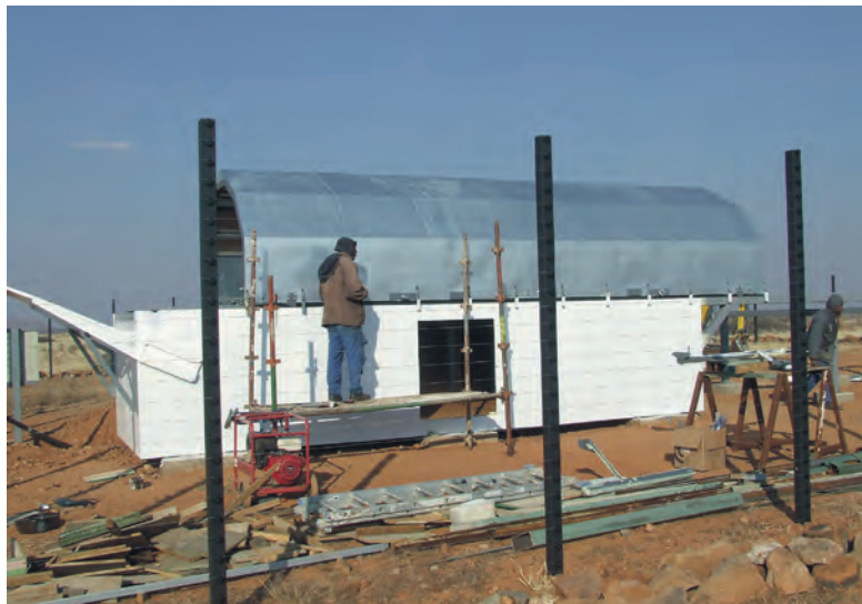
3. ábra: Az épülő, vízszintesen elhúzzható védőtetejű űrszemétfigyelő orosz távcső a namíbiai Isabis Asztrofarm mellett (A szerzők fényképe)
