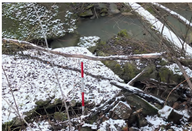
3. ábra. A Rigócz-patak betonhídja
