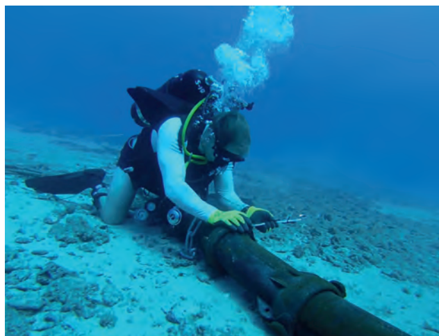
4. ábra. A Hawaii-szigeteknél futó tenger alatti optikai szálak fémburkolatának javítását képzett bűvár végzi (Forrás: U.S. Pacific Fleet )
