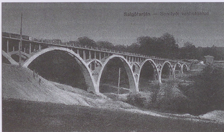
9. kép: Somlyói vasbetonhíd
