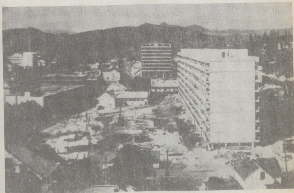
A Karancs Szálló, a „főtéri 13-as” és előtte a Pécsekő Üzletház építési területe.
