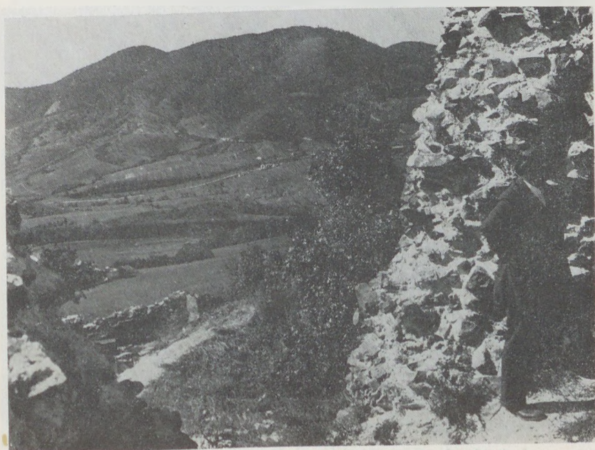
5. A torony nyugati oldalának kiszakadása, 1936.
