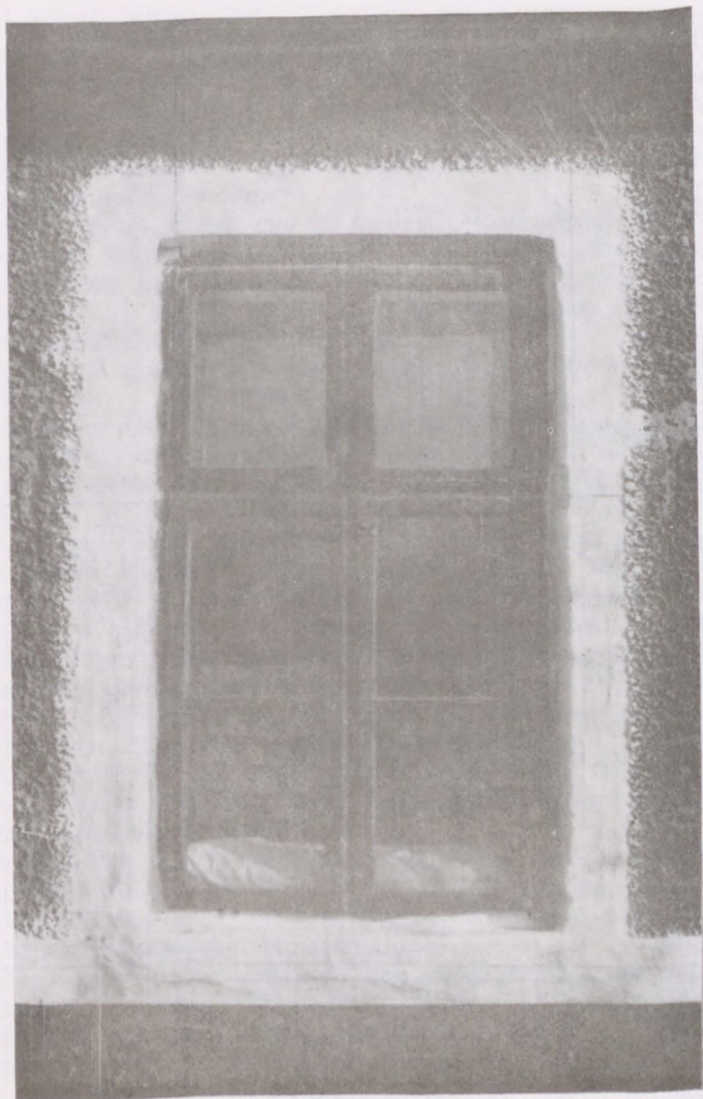
8b. ábra. Cselédház ablaka. Patvarc
