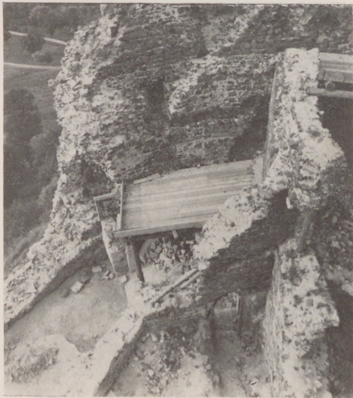
11. kép. A palota nyugati szárnya feltárás közben
