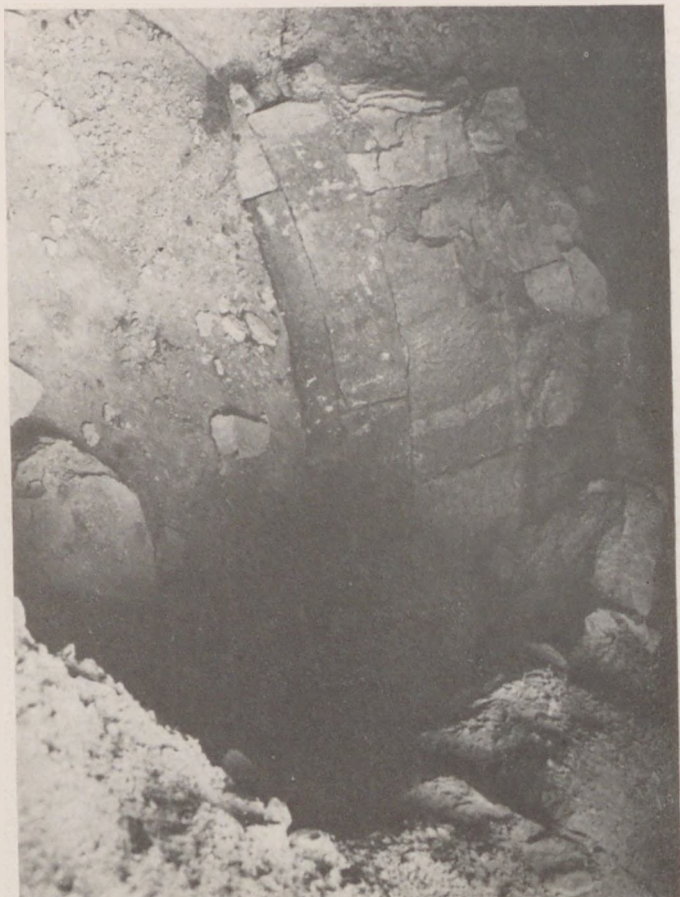
13. kép Quaderekkel bélelt vízgyűjtő, feltárás közben
