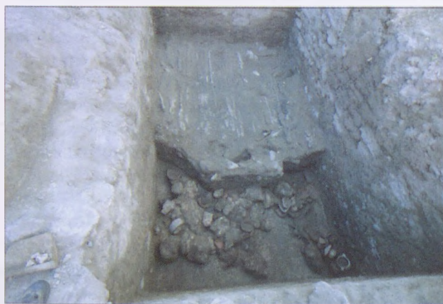
6. kép: A pince bontás közben
