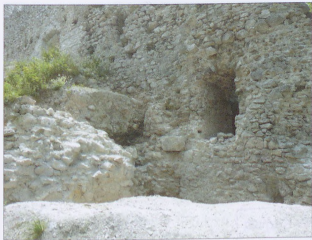
10. kép: A külső várkapu a feltárás után Abb. 10: Der äußere Burgtor nach der Freilegung
