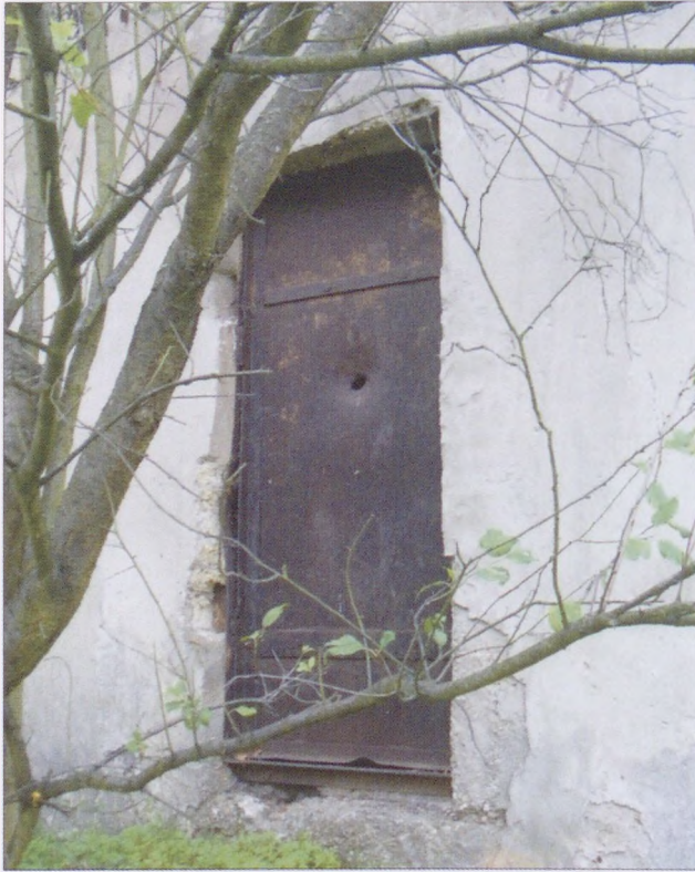
5. kép: A kiserőd lezárt bejárata Fig. 5: The closed entrance of the blockhouse
