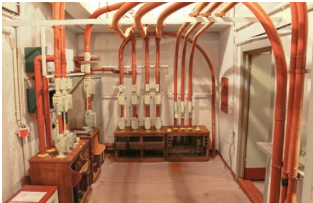
7. ÁBRA. Pneumatikus üzemeltetésű csőpostahálózat látványos részlete az egykori NDK Légierő és Légvédelmi Parancsnokság központi harcálláspontján. A Fuchsbau (Róka-lyuk) nevű objektumban kialakított rendszer hatékonyan segítette az építményen belüli kommunikációt, információáramlást (A szerző felvétele)
