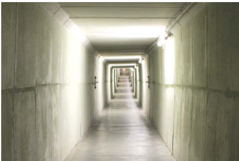
2. ÁBRA. A létesítmény főbejáratához vezető, előregyártott vasbeton idomelem szelvényekből épült hosszú és kissé emelkedő föld alatti folyosó (A szerző felvétele)
