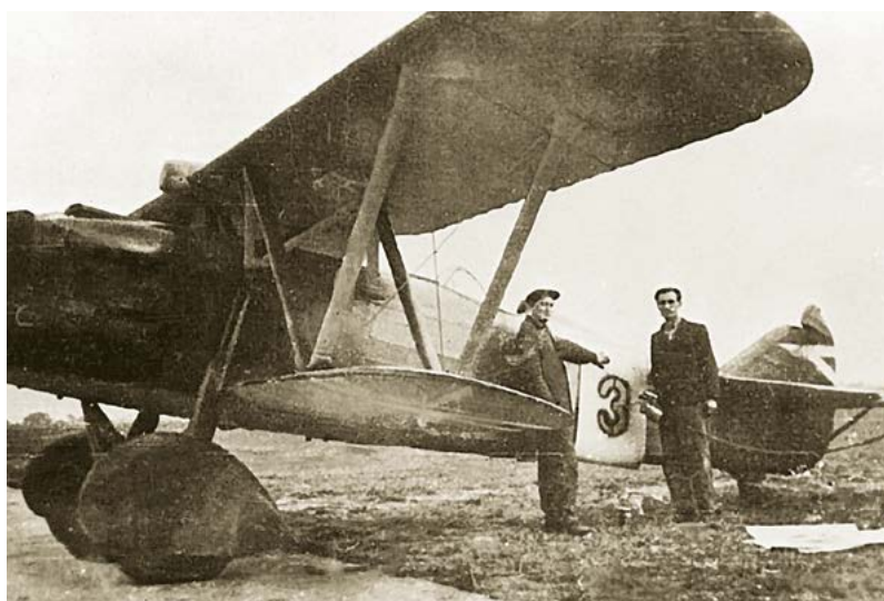
2. ÁBRA. Az oldalszám sablonnal történő felfestése a légierő FIAT CR.32 típusú vadászgépére (Fotó: Winkler archívum)
