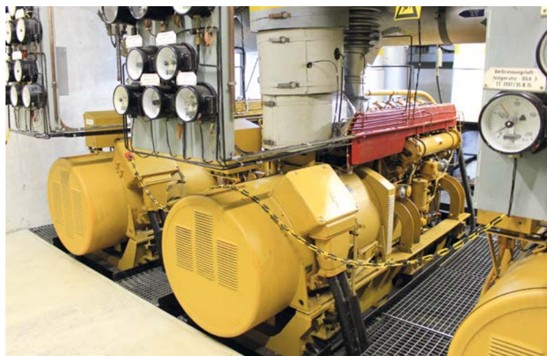
9. ÁBRA. Az egymás mellett elhelyezett három keletnémet gyártmányú dízelaggregátor (közülük az egyik tartalék) átvette a fogyasztók áramellátását a külső elektromos hálózati betáplálás megszűnésekor (A szerző felvétele)
