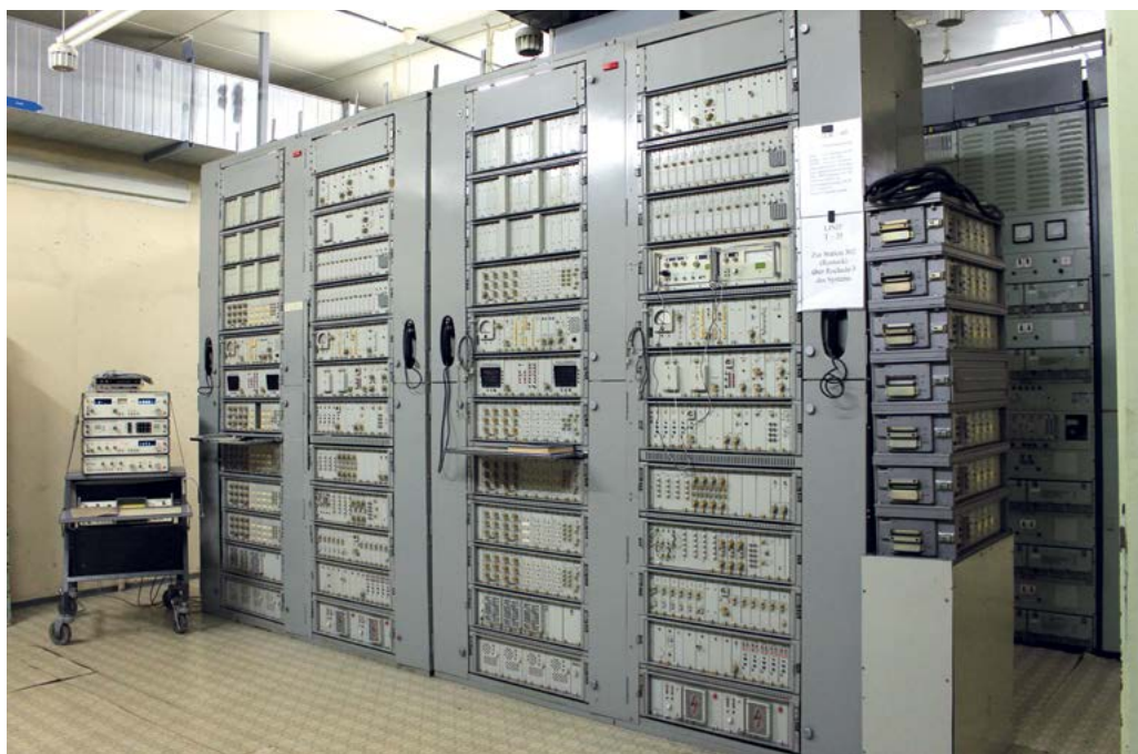
5. ÁBRA. Impozáns, szinte szobányi méretű az „Azúr – 60 SzR” típusú csatornáképző berendezés, amely biztosította a digitális adatátviteli csatornák létrehozását, rendezését (A szerző felvétele)
