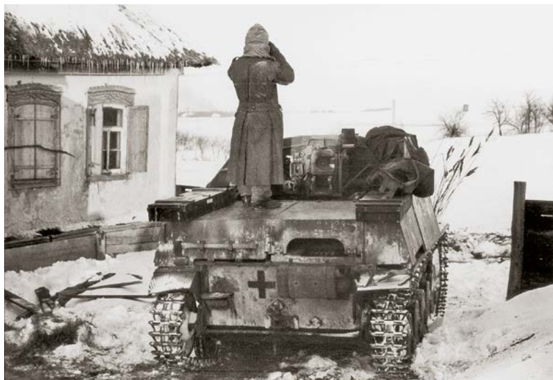
5. ÁBRA. A 4. ábrán látható páncélvadász hátulról. A motor hűtővegyője a hátsó lőszertartó alatti nyíláson lépett ki. Ennek a megoldásnak a helyigénye miatt ez a tároló egy sor (7 db) lőszerral kevesebbet tudott befogadni (Forrás: Schmidt László gyűjteményéből)
