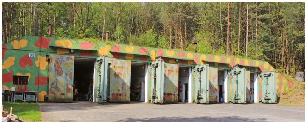
6. ÁBRA. A tartalék antennák, illetve a mobil technika tárolására szolgáló garázsok védett építménye. A beállók között közvetlen átjárási lehetőség volt a hatalmas kétszárnyú védőajtók mögött (A szerző felvétele)
