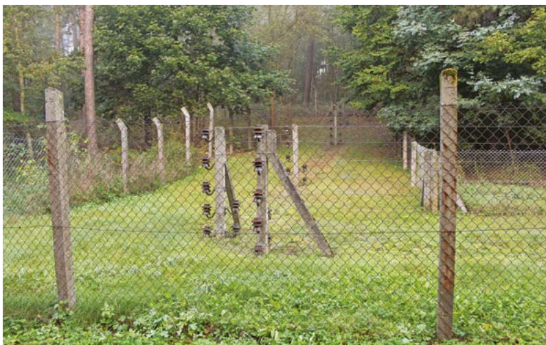
3. ÁBRA. A bázis területe körül húzódó háromsoros kerítésrendszer, ahol a biztonsági sáv közepén fut a porcelánszigetelőkkel ellátott nagyfeszültségű szakasz (A szerző felvétele)
