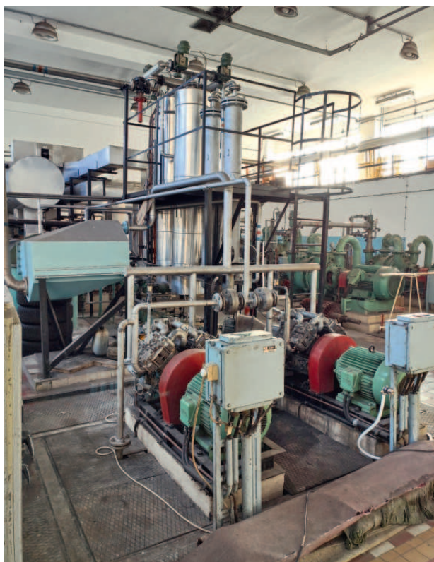
3. ÁBRA. Lépellátó rendszer: hűtőtornyok és kompresszorok a gépteremben (háttérben a bányászvattyúk) (A szerző archívumából)
