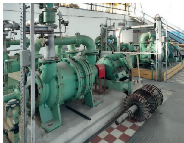
5. ÁBRA. A vákuumrendszer szivattyúi (A szerző archívumából)
