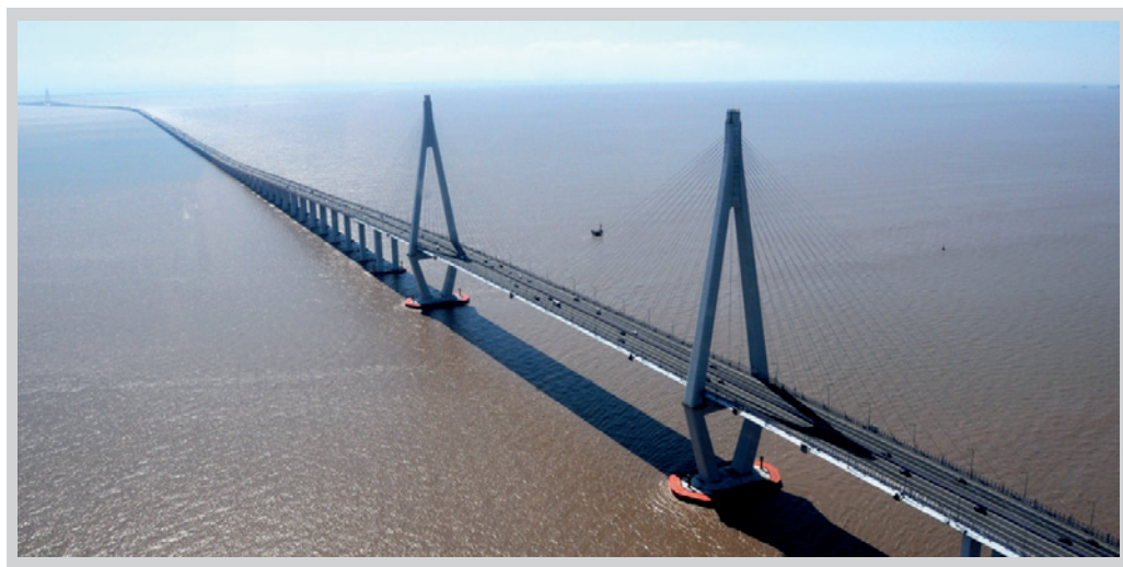
12. ábra. A Föld leghosszabb hídja a Hangcsoui-öböl (Hangzhou Wan) felett (forrás)
