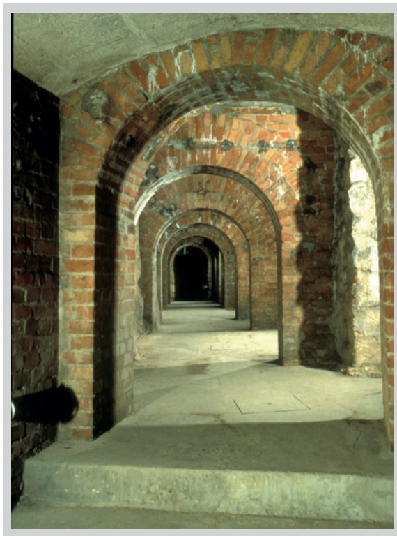
6. ábra. Téglaiíves falazású pincegádor az óvóhely-szakasz elején (fotó: Borzsák Péter)
