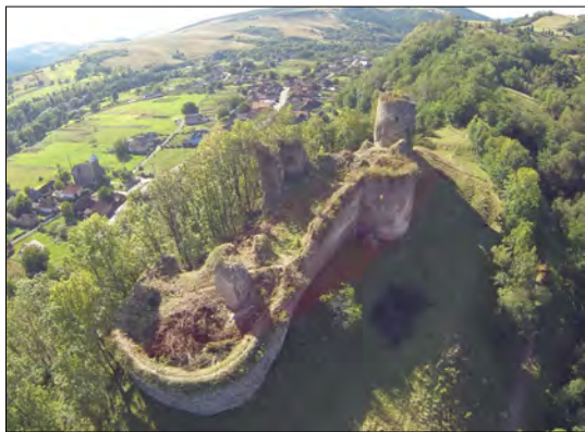
5. ábra. A sebesvári vár felújítás előtti állapota
