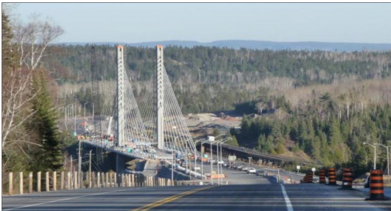
1. ábra: A Nipigon folyó feletti ferdekábeles híd, pályalemezében hosszirányú FRP betétekkel (Benmokrane & Mohamed, 2018)
