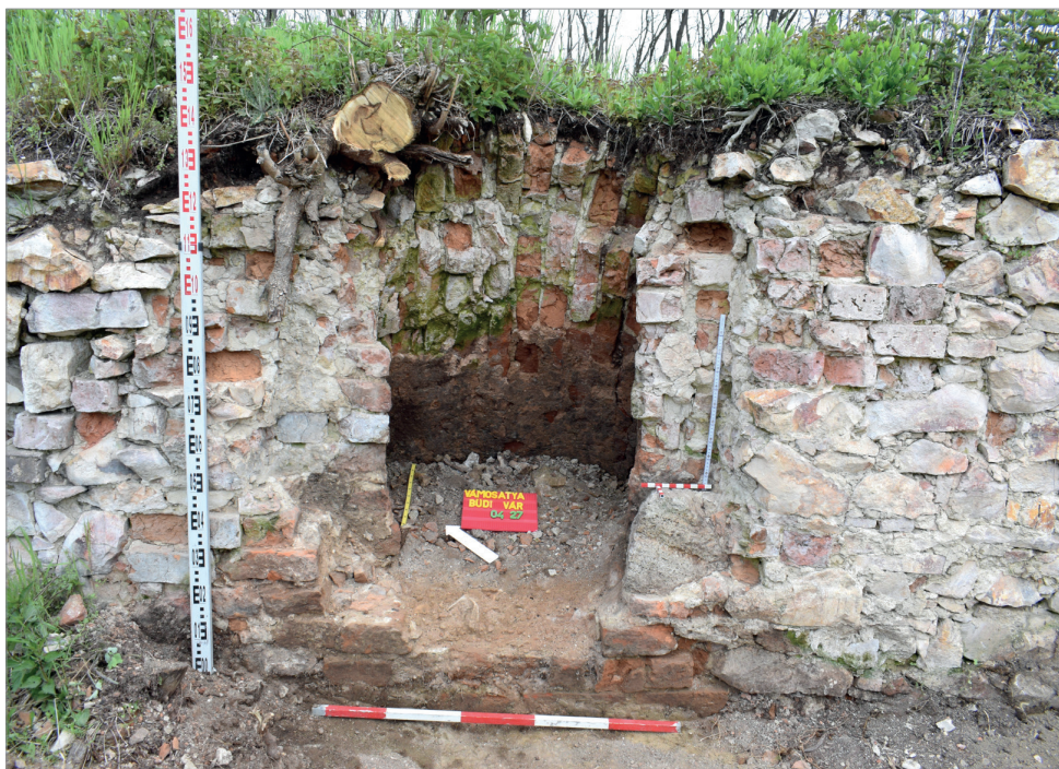
9. kép: A 4. helyiséget megvilágító pinceablak a helyreállítás előtt (a szerző fényképe)
