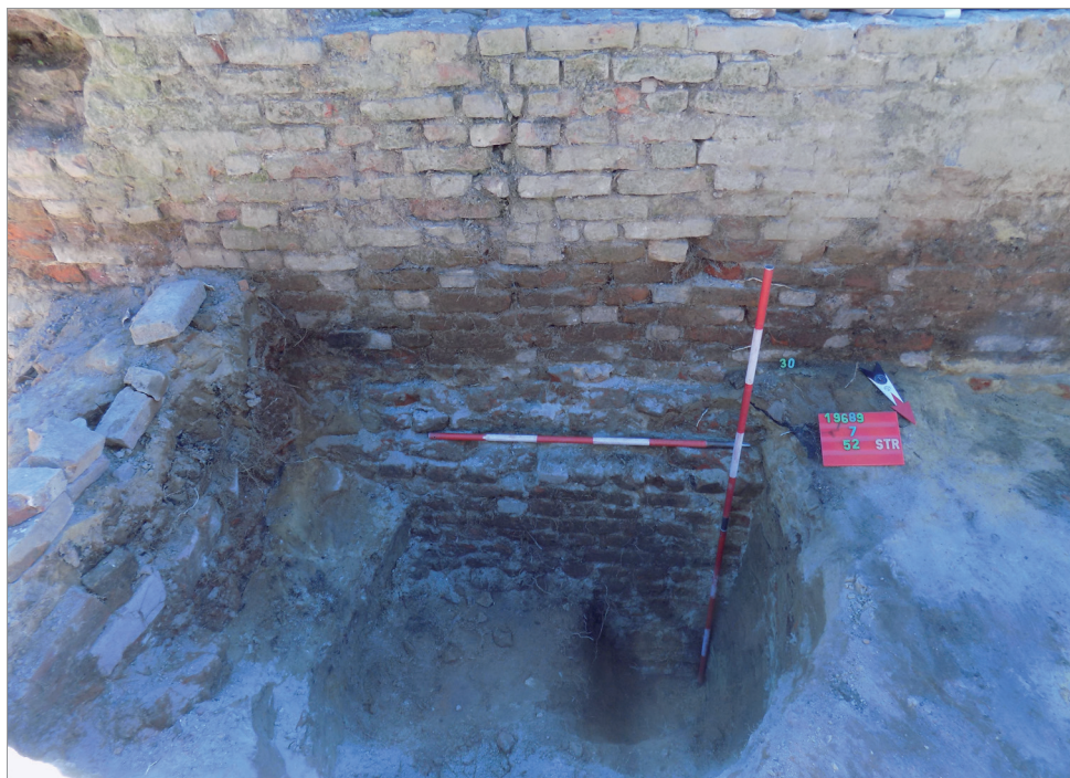
6. kép: A délnyugati várfal alapozása a 7. szelvényben
