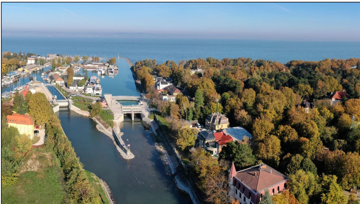
1. kép. Siófoki zsiliprendszer és közösségi tér (Fotó: KDTVIZIG) Image 1. Siófok lock system and community space (Photo: KDTVIZIG)
