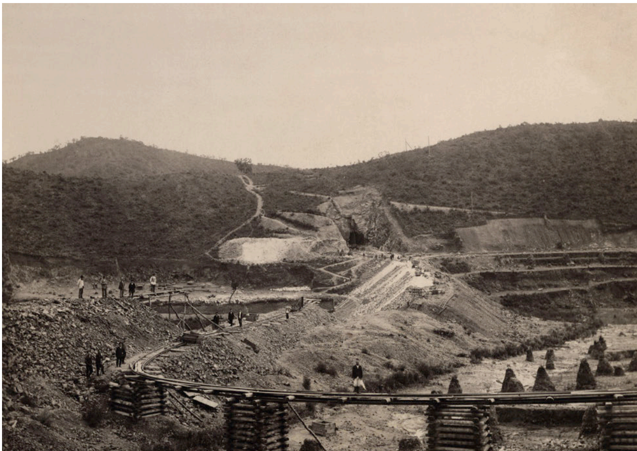
12. kép. A mandzsúriai vasút Nikolszk–Ninguta-szakaszának építése. Az alagutat Gubányi Károly építette. Forrás: MFM_Erd_Gubanyi_5879_20032
