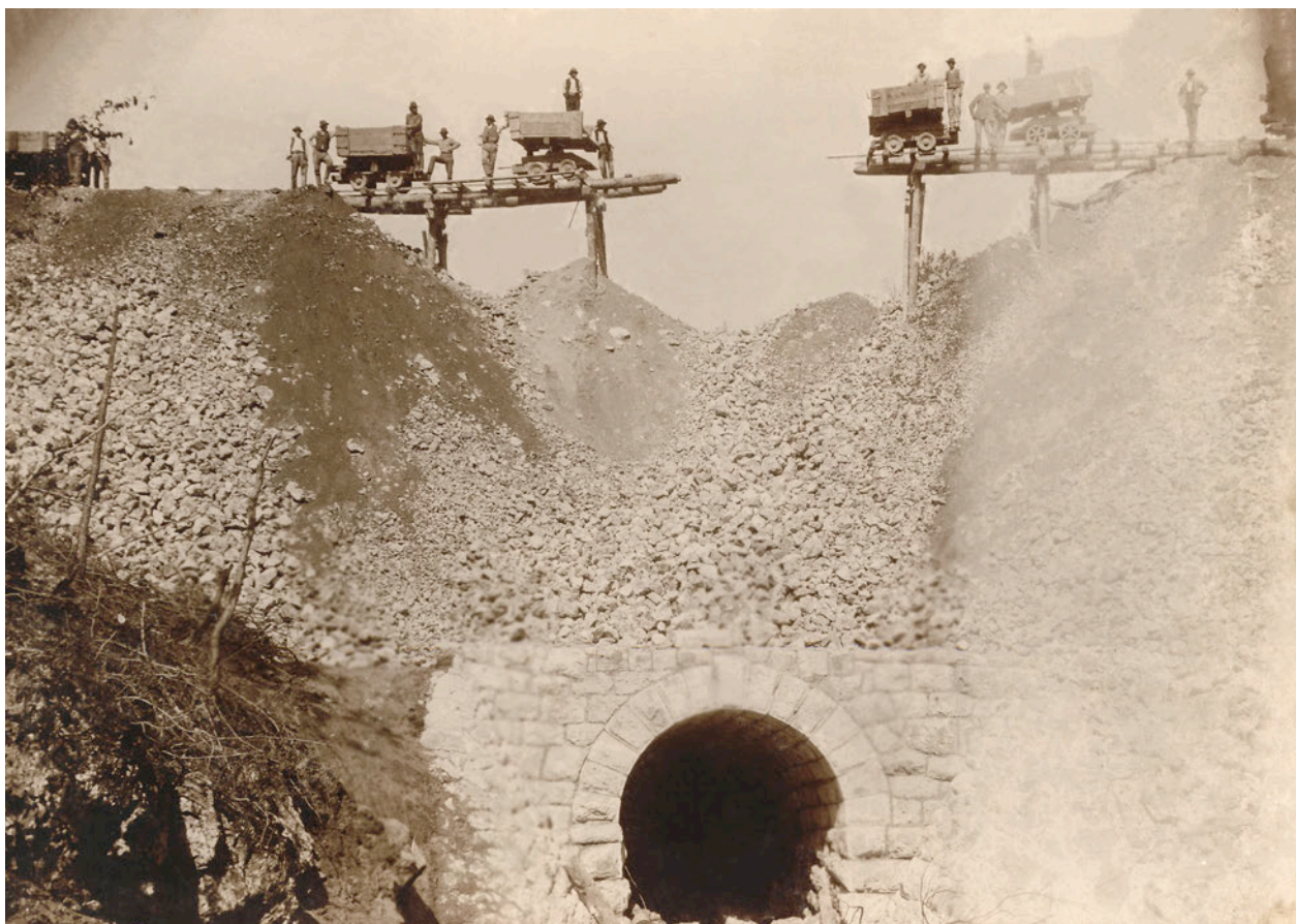
6–8. kép. A Cuha-völgyi viadukt építésén. Forrás: MFM Érd
