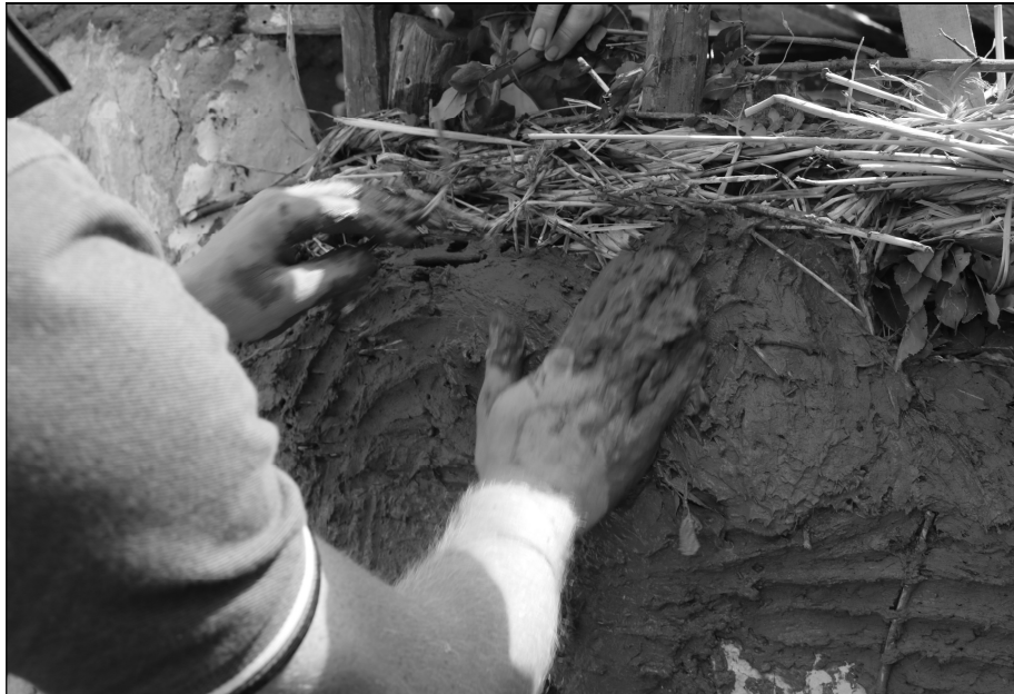
Sártapasztás a Népi Építészeti Nyári Egyetemen, Felpéc, 2018 (Fotó: Bereczki Ibolya)
