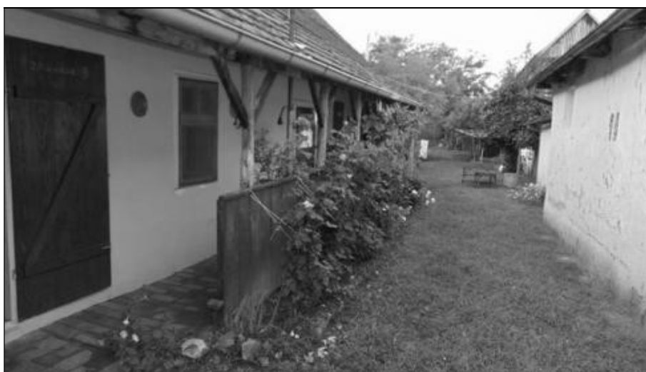
Fejértelepi régi lakóház
