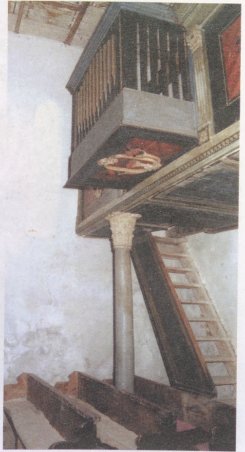
22. kép A másodlagosan beépít- ett copf mellvédlap az orgona alsó részén (Kenéz Pál felvétele) Abb. 22 Gyügye, die am unteren Teil der Orgel sekundär eingebaute Zopfstilkassette (Foto: Pál Kenéz)
