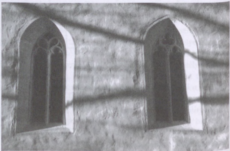
13. kép A hajó ablakai Abb. 13 Die Fenster im Kirchenschiff
