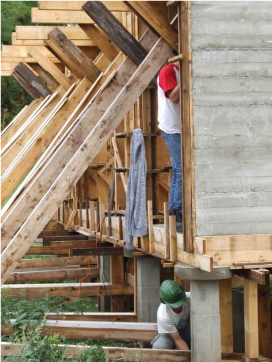
Vasbeton kukoricagóré szerkezetépítése. 2013, Perbál. Fotó: Révai Virág
