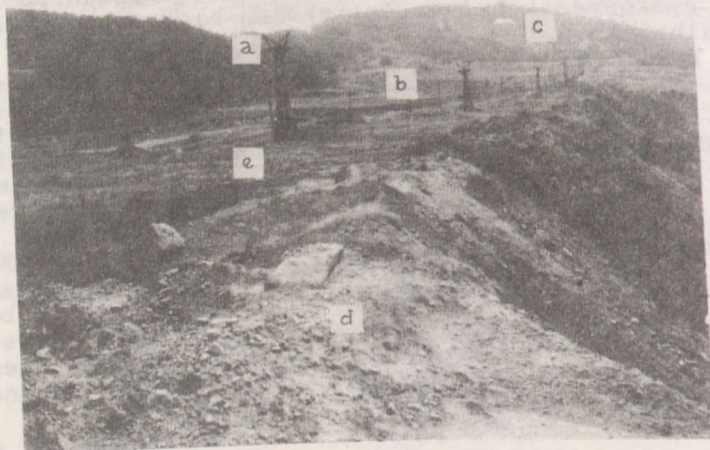
5. ábra: Meddőhányó a Budafai-völgyben /1990. július/: a = kötélpálya; b = "potyogtató-hely" a csillékből; c = III-as akna.
