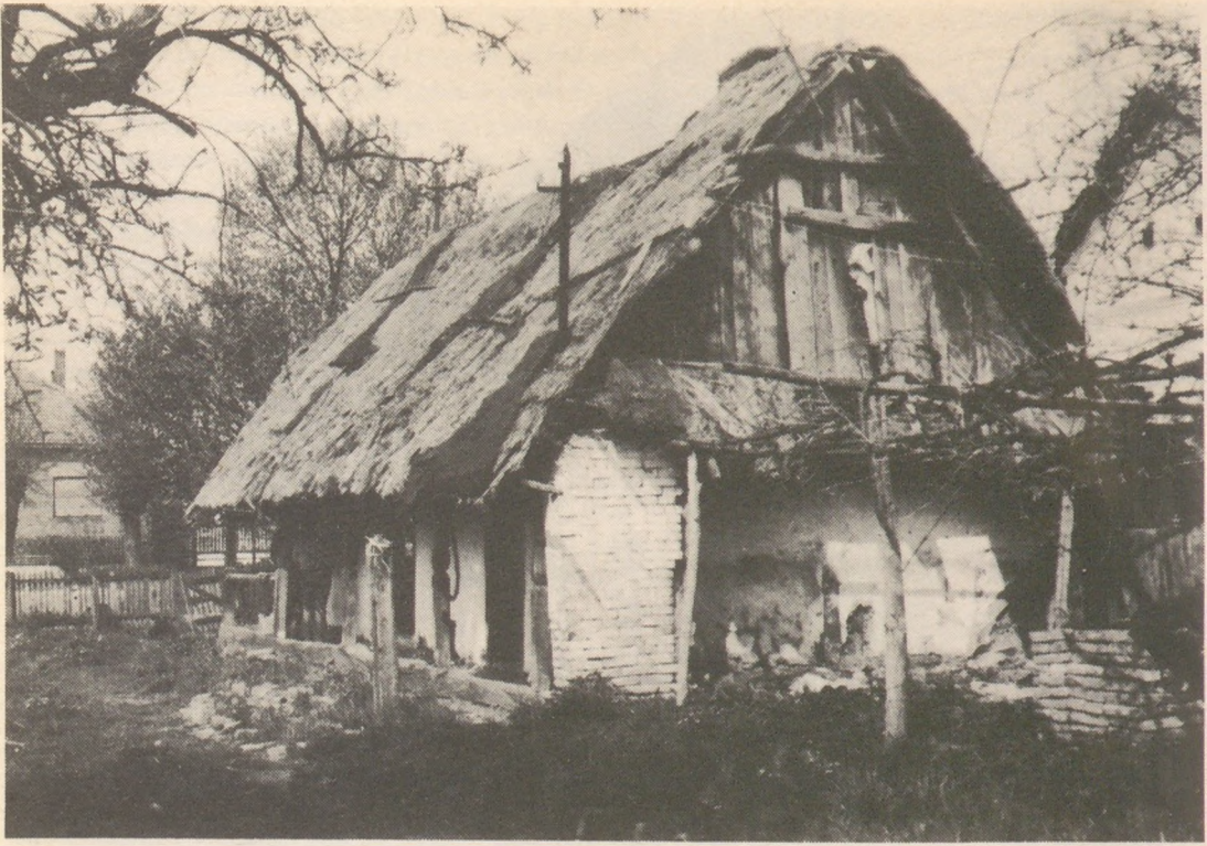
A LAKÓHÁZ UDVARI HOMLOKZATA
