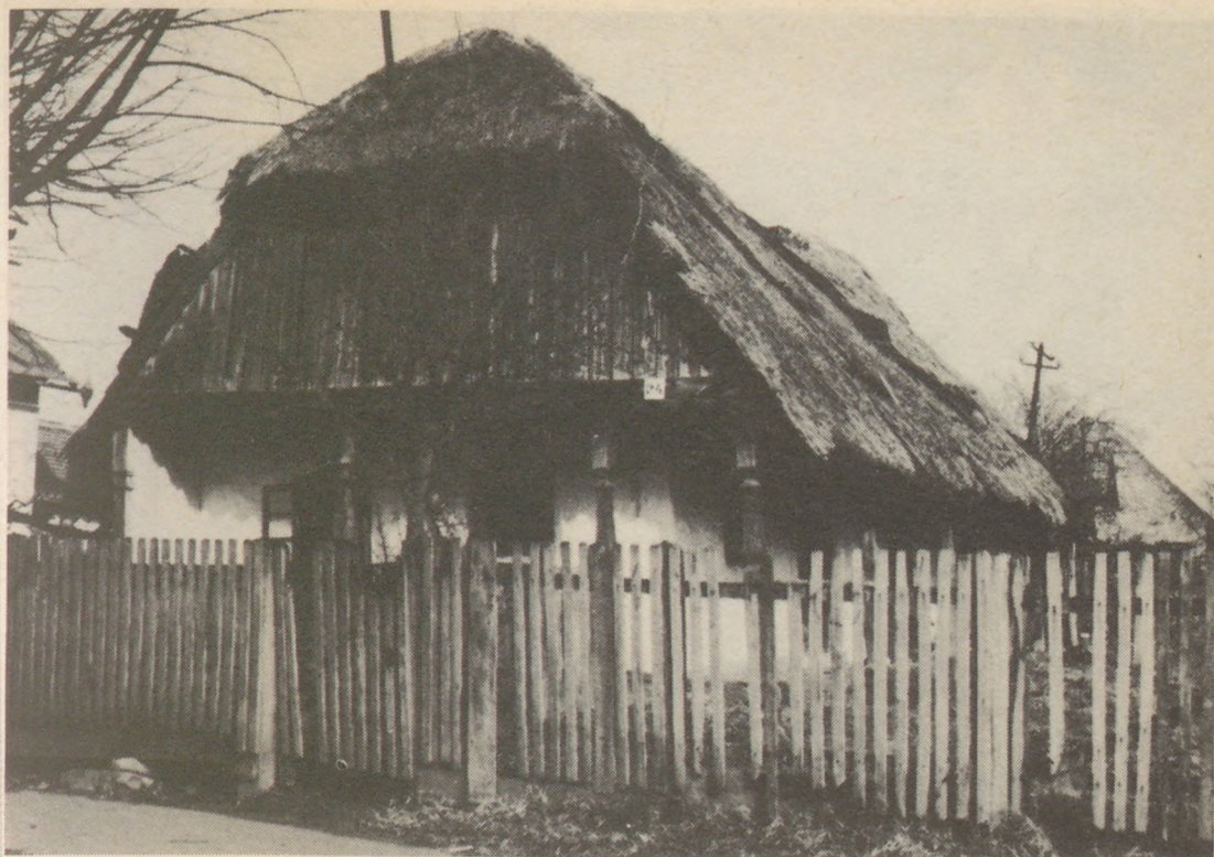
A GIGEI LAKÓHÁZ EREDETI HELYÉN, BONTÁS ELŐTT
