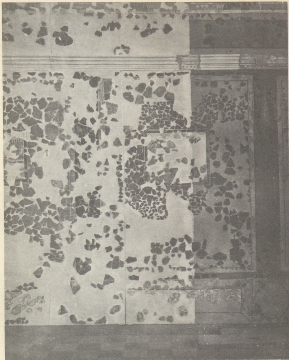
A HOSSZANTI OLDALFAL A BEÉPÍTÉSKOR SZÍNEZÉS ELŐTT
