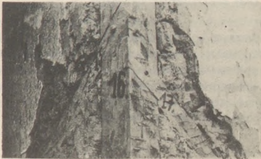
BONTÁSI MUNKA. A TARPAI HÁZ LÁBFÁINAK SZÁMOZÁSA, FALBONTÁS UTÁN
