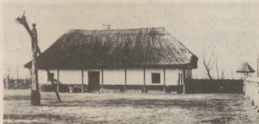
A JÁNKMAJTISI LAKÓHÁZ
