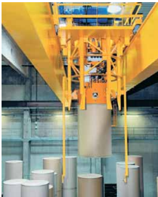
A daruk vákuumemelővel vannak felszerelve, kapacitásuk 5 tonna
