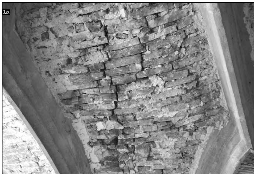
■ Foto. 3. a. Zidul nordic al bisericii din Sic după decaparea tencuielilor © SC IROD M SRL, b. Pânza de boltă tip plasă din corul bisericii reformate de pe strada Kogălniceanu © SC IROD M SRL ■ Photo. 3. a. The northern wall of the Sic Calvinist church after removing the layers of plaster © IROD M Ltd., b. The net vaulting over the choir of the Calvinist church in Kogălniceanu Street © IROD M Ltd.
