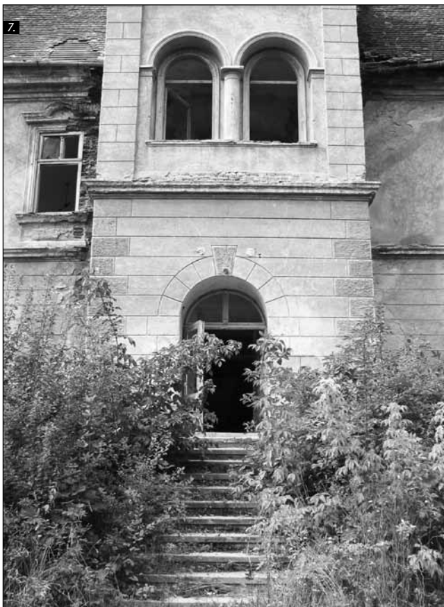
■ Foto 7. Intrarea în corpul principal al conacului. Înălțată față de teren, intrarea este precedată de un portic accesibil printr-o rampă de trepte din piatră © Andreea MILEA, 2010
