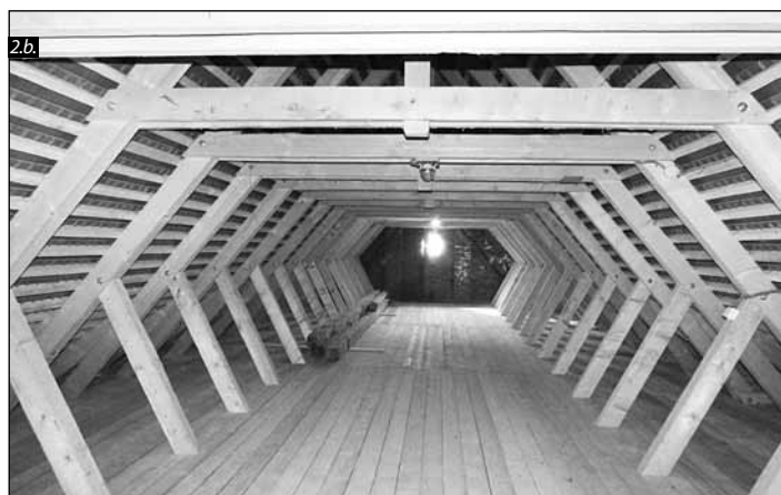
■ Foto. 2. a. Șarpanta bisericii reformate de pe strada Kogălniceanu – după reabilitare © SC IROD M SRL, b. Șarpanta bisericii reformate din Sic finalizată © SC IROD M SRL
