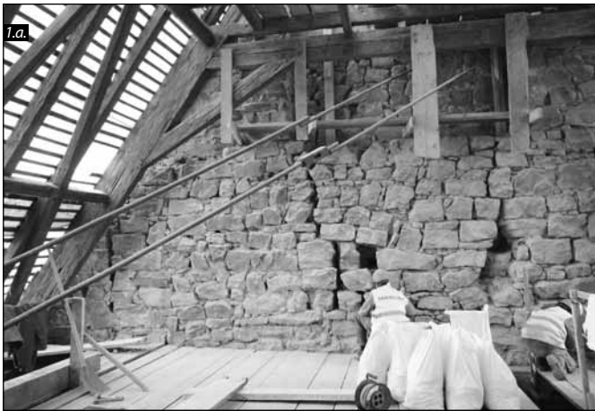
■ Foto. 1. a. Fisurarea timpanului după curățarea rosturilor © SC IROD M SRL, b. Fisurile bolții peste a doua travee din navă după curățare – Biserica de pe strada Kogălniceanu © SC IROD M SRL
