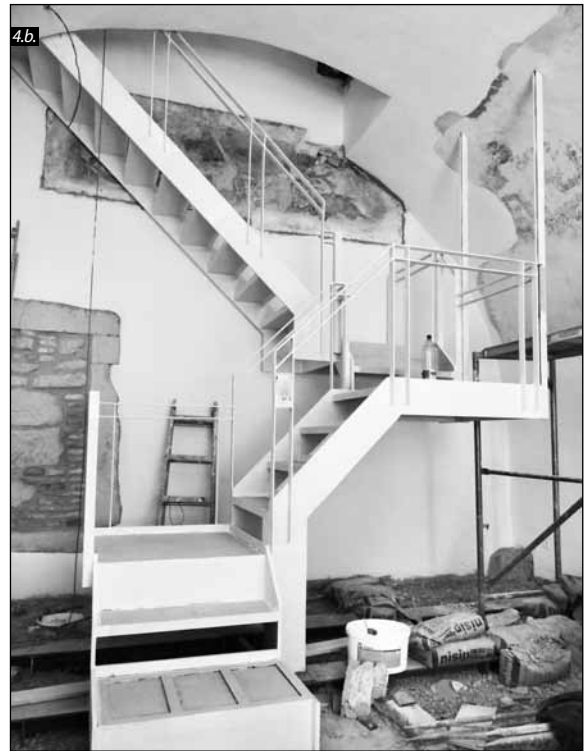
■ Fig. 4. a. Modelul static spațial al scărilor dintre parterul porticului claustrului și etajul 1 al turnului, b. Scheletul metalic al scărilor dintre etajul 1 și etajul 2 al turnului – Biserica reformată de pe str. Kogălniceanu © SC IROD M SRL
