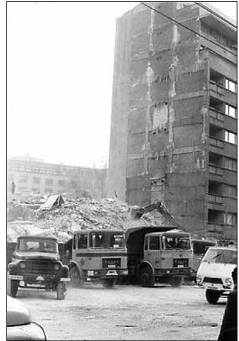
■ Foto 4. Blocul Scala, 4 martie 1977 ■ Photo 4. Scala Apartment Block, March 4, 1977
