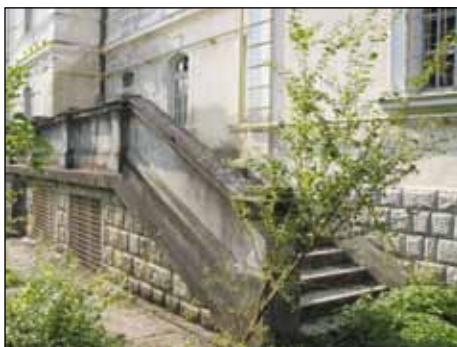
■ Foto 6. Terasa descoperită de la nivelul parterului, pe fațada nord-estică a castelului. © Andreea MILEA, 2014
