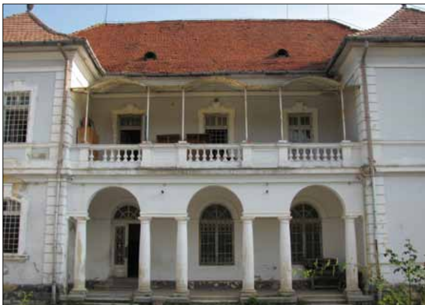
■ Foto 5. Zona centrală a fațadei sud-vestice a castelului. Se observă terasa și porticul de la nivelul parterului, terasa etajului, precum și actuala structură parazitată de acoperire a acesteia din urmă. © Andreea MILEA, 2014
