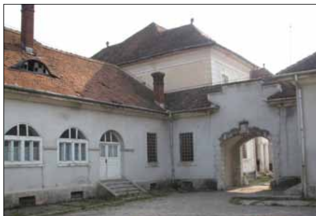
■ Foto 4. Gangul de legătură dintre curtea de acces și peronul prevăzut între fațada sud-vestică a castelului și grădina ornamentală. © Andreea MILEA, 2014
