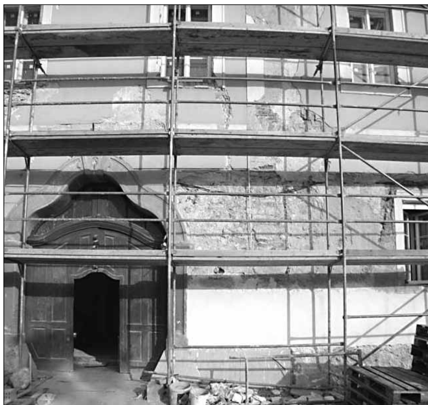
■ 7. kép: Homlokzati falkutatás
