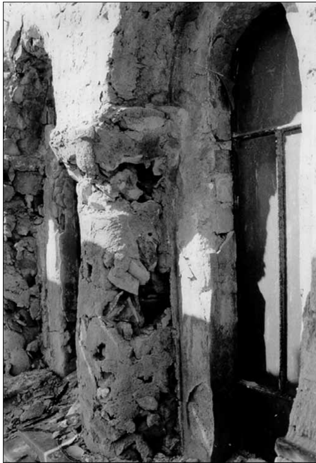
■ 8. kép: Homlokzatrekonstrukció ■ Photo 8. Reconstruction of an elevation
