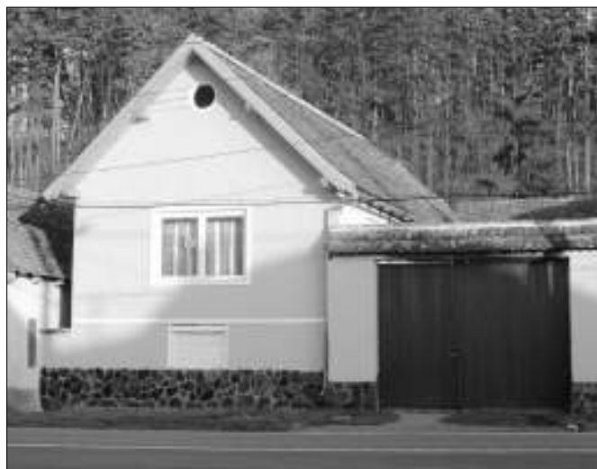
■ Foto 3. Casă renovată în Saschiz ■ Photo 3. Renovated house in Saschiz
