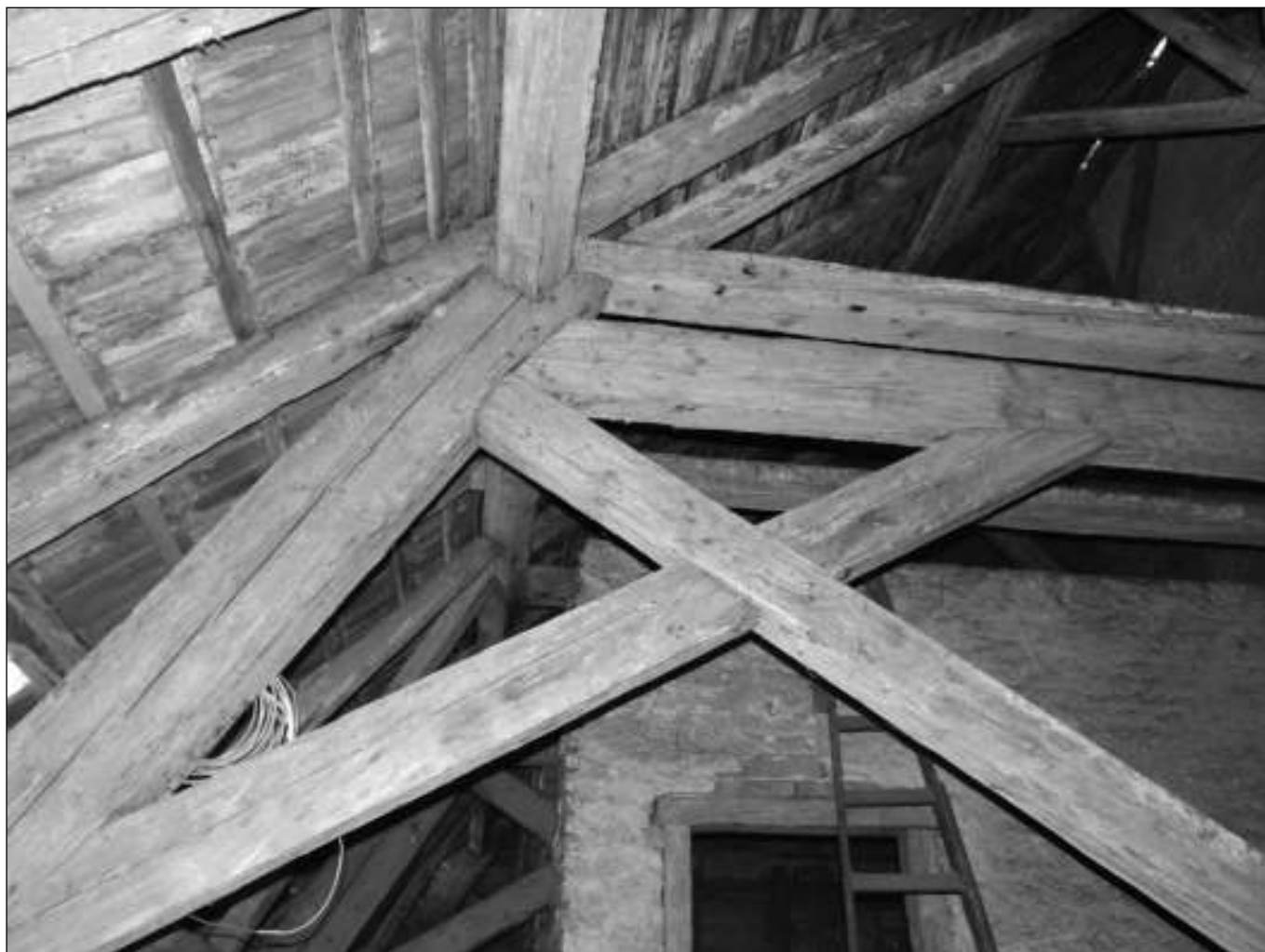
■ Foto 2. K13: soluție locală de rigidizare cu colțar suplimentar perpendicular ■ Photo 2. K13: local bracing solution with supplementary perpendicular angle brace
