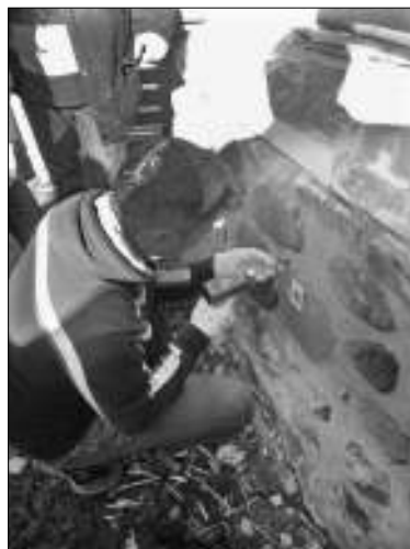
■ Foto 5. Prelevare de mostră de mortar ■ Photo 5. Mortar sampling
