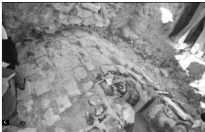
■ Foto 6. Bolta cilindrică din piatră refăcută la turnul de vest. © UTILITAS. ■ Foto 7. Fațada de vest al turnului de est, cu golul de acces, al încăperii de la parter, după degajarea umpluturilor. © UTILITAS ■ Photo 6. Rebuilt stone barrel vault at the western tower. © UTILITAS. ■ Photo 7. The western elevation of the eastern tower, with the access to the ground floor room, after the removal of the filling. © UTILITAS
