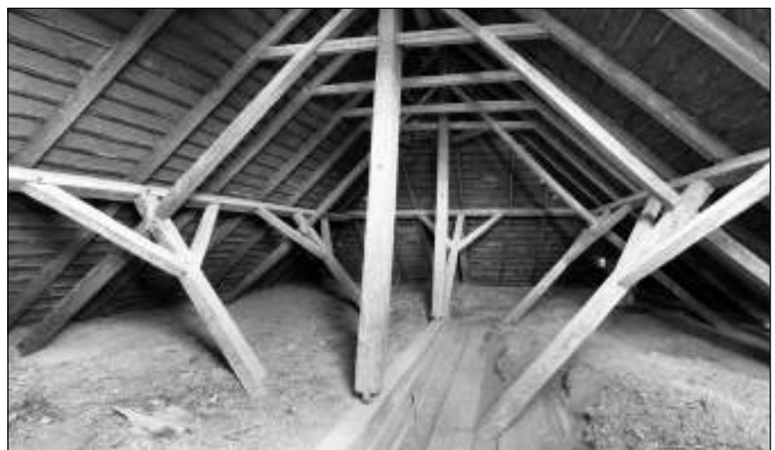
■ Foto 2. Șarpantă navă. © Adrian TUDOREANU ■ Photo 2. Nave roof structure. © Adrian TUDOREANU
