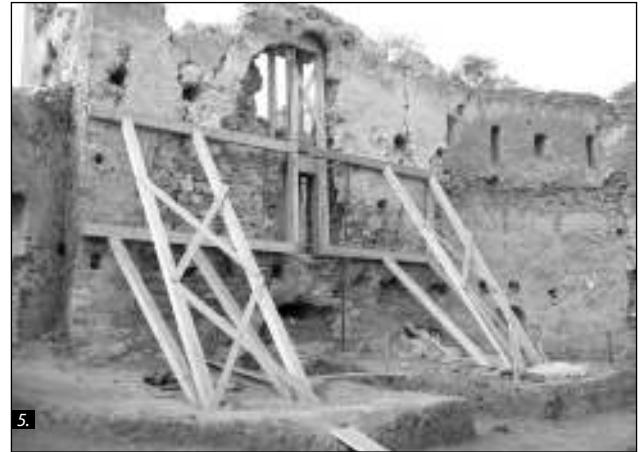
■ Foto 4. Cetatea văzută dinspre latura de S-V, cu turnul de vest și zidul de zwinger completat parțial (2013). © UTILITAS. ■ Foto 5. Turnul de vest cu sprijiniri provizorii, vedere dinspre interiorul incintei (2013). © UTILITAS ■ Photo 4. The fortress seen from the S-V side, with the western tower and the completed partially zwinger wall (2013). © UTILITAS. ■ Photo 5. Western tower with provisional buttress, seen from the enclosure (2013). © UTILITAS
