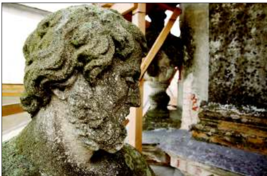
■ Foto 12. Atacul biologic și erodarea suprafețelor este mai pronunțată pe latura nordică ■ Photo 12. Biologic attack and erosion of the surfaces is more accentuated on the northern side
