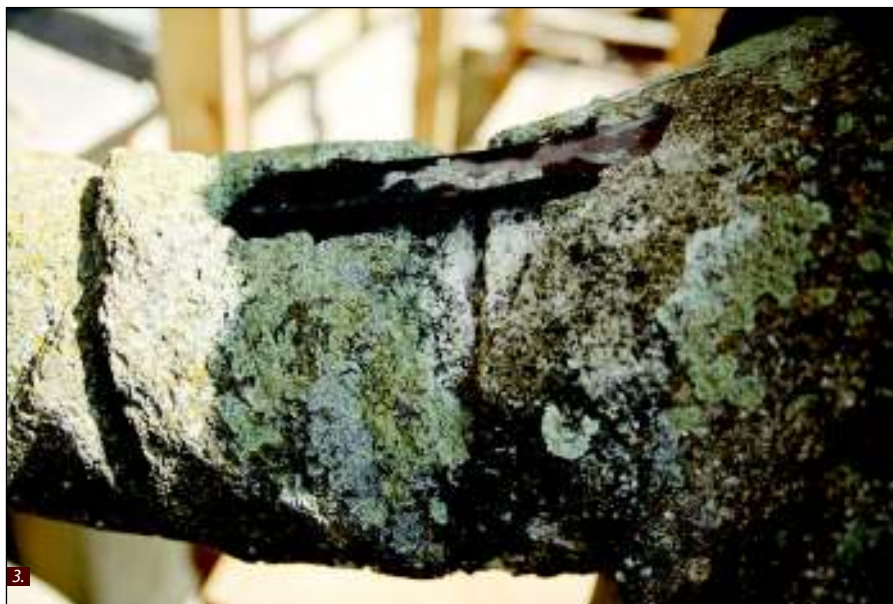
■ Foto 3. Scoabe metalice corodate ■ Foto 4. Statuia superioară de la colțul sud-estic al turnului ■ Photo 3. Corroded metal rods ■ Photo 4. The upper levels' statue from the south-eastern corner
