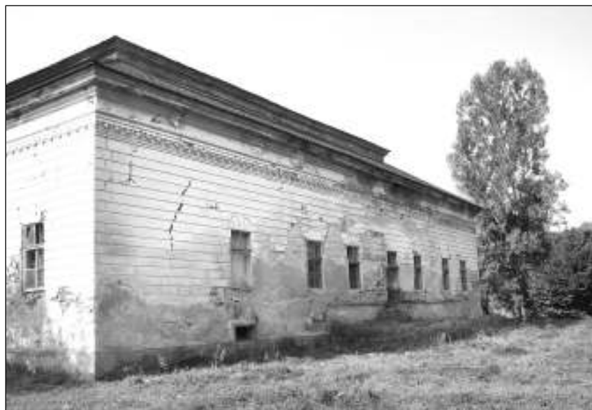
■ Foto 12. Fațada nordică a castelului cu intrarea precedată de ceea ce a rămas dintr-o terasă înălțată de la teren (2007). © Andreea MILEA
