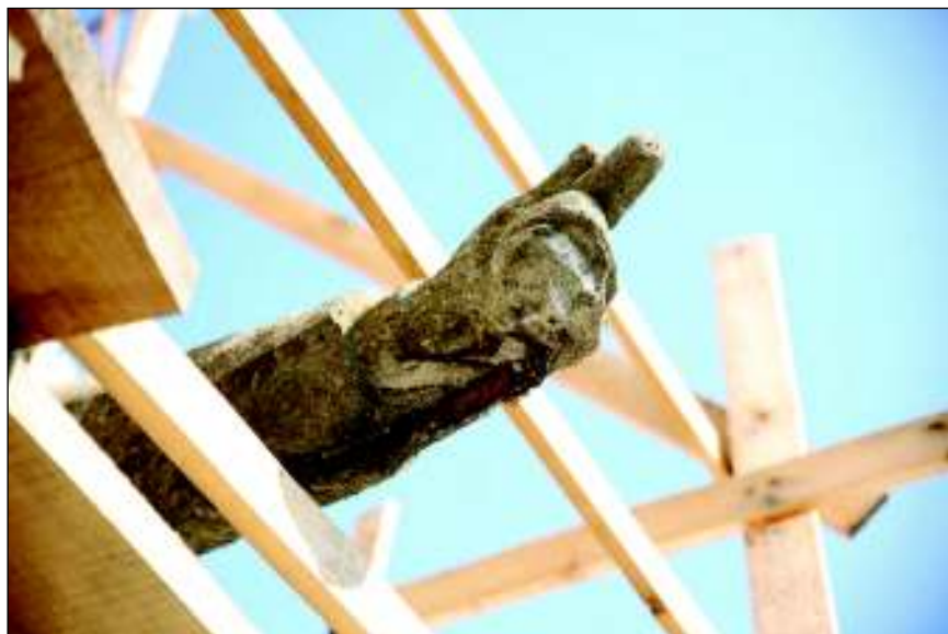
■ Foto 1. Mână reconstituită din mortar de ciment ■ Photo 1. Rearrangement of one hand out of cement mortar
