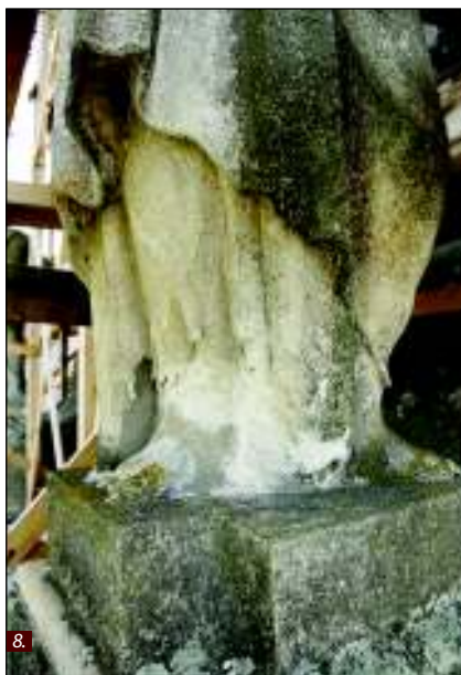
■ Foto 8. Degradări caracteristice părții inferioare a statuilor
