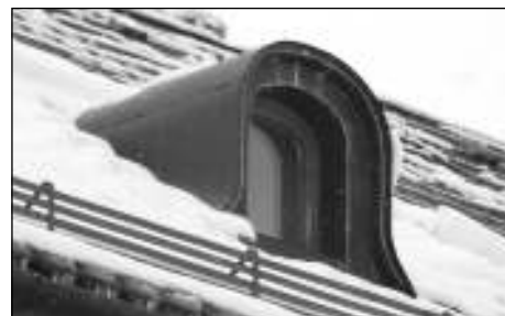
■ 12. kép: Az eredeti formát követő tetőtéri ablak. © UTILITAS
