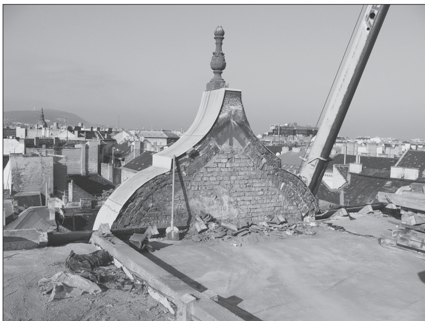
■ Foto 9. Felújítási munkálatok a tetőn
