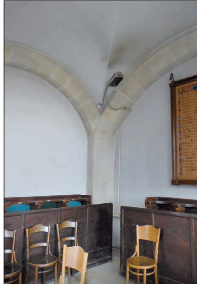
■ 5. kép: A kolozsvári/Cluj-Napoca (Kolozs megye) Farkas utcai református templom egyik gázmelegítésű IR sugárzója fölött látható feketedés és a szükséges gázvezeték látványa.
