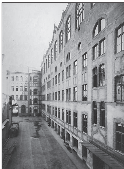
■ 2. kép: Budapesti Terézvárosi Telefonközpont udvari homlokzata, archív felvétel ■ Photo 2. Telephone Central Office of Terézváros District courtyard elevation, archive photo
