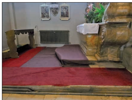
■ 17. kép: A Nagyszeben/Sibiu (Szeben megye) központjában levő római katolikus templom meleg vizes padfűtése és egy a mellékoltárokból elhelyezett fűtőtestek közül. ■ Photo 17. Hot-water operated pew heating in the Catholic church of downtown Sibiu (Sibiu County) and one of the radiators placed in the side altars.
