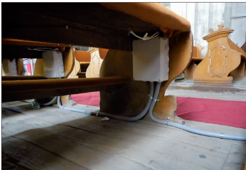
■ 12. kép: A kolozsvári/Cluj-Napoca (Kolozs megye) Szent Mihály katolikus plébániatemplom fűtését biztosító négy meleg levegőt befújó generátor egyikének ide nem illő látványa (balra). 2012 telén a templomban megkezdték a fűtőfóliás padfűtés beszerelését (részletfotó jobbra). ■ Photo 12. S. One of the four ugly generators blowing in warm air ensuring the heating of St. Michael's Catholic Church in Cluj-Napoca (Cluj County) (left photo). In the winter of 2012 they started building in the heating film pew heating in the church (detail on the right photo).
