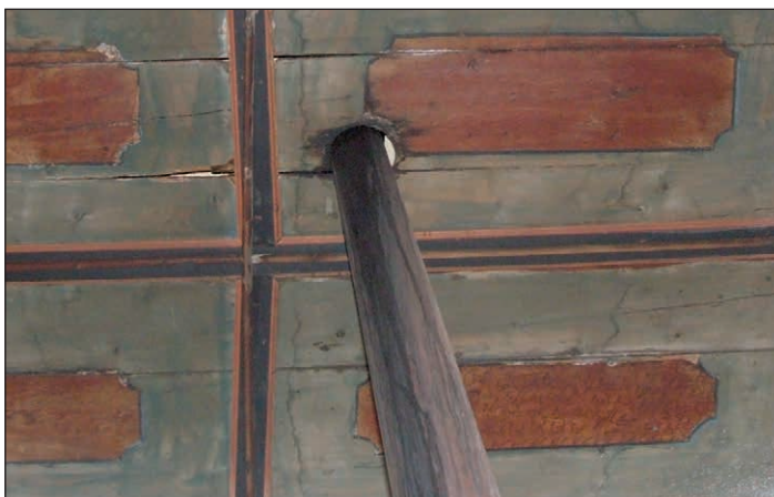
■ 6. kép: A magyarhermányi/Herculian (Kovászna megye) református templomban a kályhacsövet a XVIII. század második felében készült kazettás mennyezetén keresztül vezették ki. (Fotó © MIHÁLY Ferenc).
