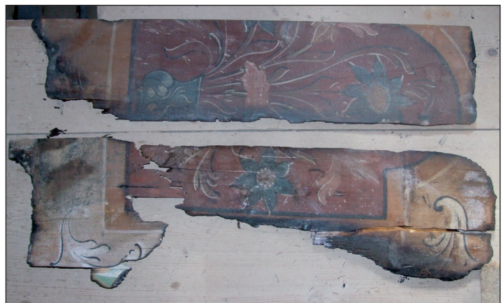
■ 10. kép: Az illyefalvi/Ilieni (Kovászna megye) református templom túlfűtött kályhája miatt kigyúlt a templom karzata. A tűz szerencsére lefulladt, de a XVIII. századi karzattmellvéd pár kazettája visszafordíthatatlanul károsodott. (Fotó © MIHÁLY Ferenc)
