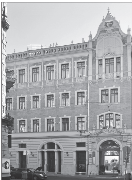
■ Foto 6. A telefonközpont főhomlokzata a felújítás után
