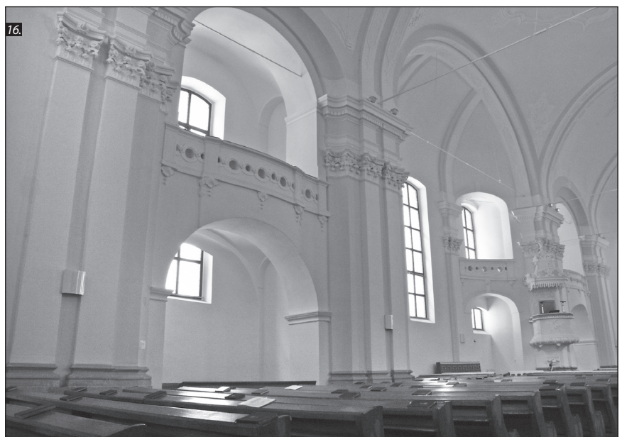
■ Foto 15. Biserica unitariană din Cluj-Napoca, fațada vestică ■ Foto 16. Intervenție de excepție la Biserica Unitariană din Cluj-Napoca la insuficiență care persista de secole: tiranți metalici la nivelul nașterii bolților de mare deschidere
