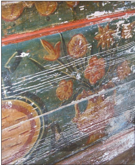
■ 1. kép: A viski/Viskove (Ukrajna) református templom XVIII. századi padmellvédje a kályha közelsége miatt károsodott. (Fotó © MIHÁLY Ferenc) ■ Photo 1. The pew parapet in the Calvinist church of Viskove (Ukraine) dating back to the 18 th century was damaged because of the proximity of the stove. (Photo © Ferenc MIHÁLY)
