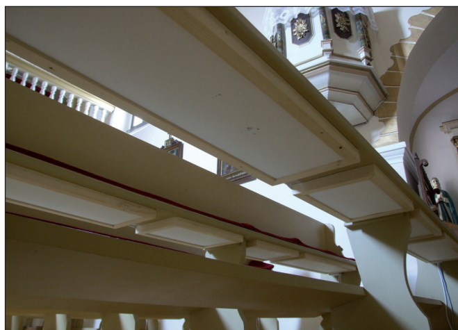
■ 16. kép: Csíkkarcfalván/Cârța (Harghita megye), a katolikus templomba, a nemrég befejezett teljes felújítás alkalmával vezették be a képen látható padfűtést (Fotó © MIHÁLY Ferenc).
