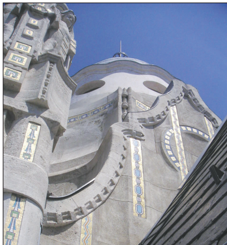
■ 6. kép: Az újjáépített északi torony ■ Photo 6. The rebuilt northern tower
