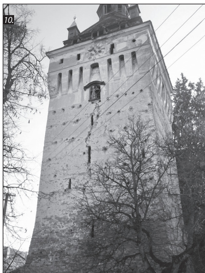
■ Foto 9. Acțiuni de excepție provocând insuficiențe provenite din: curgerea lentă a versantului la Biserica Evanghelică din Copșa Mare ■ Foto 10. Acțiuni de excepție provocând insuficiențe provenite din: activitate seismică la turnul Bisericii Evanghelice din Saschiz
