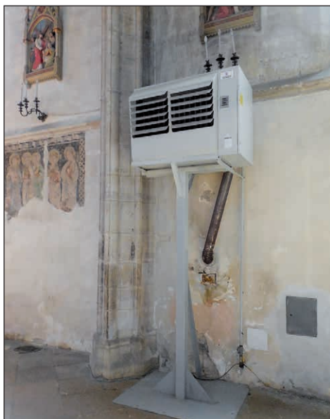
■ 12. kép: A kolozsvári/Cluj-Napoca (Kolozs megye) Szent Mihály katolikus plébániatemplom fűtését biztosító négy meleg levegőt befújó generátor egyikének ide nem illő látványa (balra). 2012 telén a templomban megkezdték a fűtőfóliás padfűtés beszerelését (részletfotó jobbra). ■ Photo 12. S. One of the four ugly generators blowing in warm air ensuring the heating of St. Michael's Catholic Church in Cluj-Napoca (Cluj County) (left photo). In the winter of 2012 they started building in the heating film pew heating in the church (detail on the right photo).
