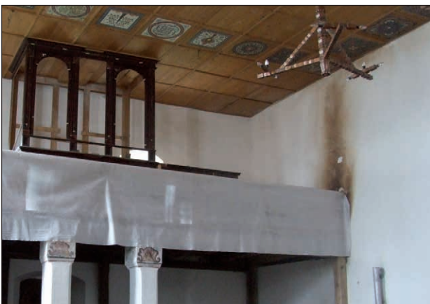
■ 10. kép: Az illyefalvi/Ilieni (Kovászna megye) református templom túlfűtött kályhája miatt kigyúlt a templom karzata. A tűz szerencsére lefulladt, de a XVIII. századi karzattmellvéd pár kazettája visszafordíthatatlanul károsodott. (Fotó © MIHÁLY Ferenc)
