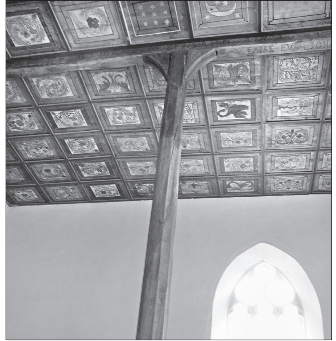
■ Foto 6. Elemente de structură portantă istorică: stâlp din lemn, parte din sistemul de susținere a tavanului casetat ■ Photo 6. Historic load-bearing structure elements: timber pillar, part of the supporting system for the coffered ceiling
