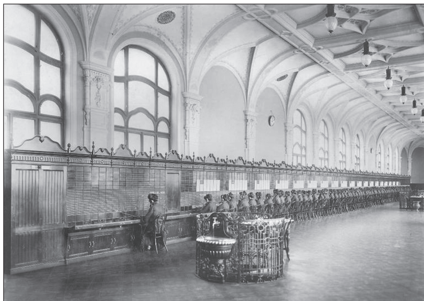
■ Foto 3. Harmadik emeleti nagyterem, eredetileg kézi kapcsolóterem volt ■ Photo 3. The hall on the 3 rd floor, originally it hosted the manual switchboards
