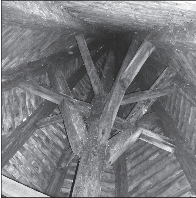
■ Foto 5. Elemente de structură portantă istorică: catarg la o șarpantă spațială cu caracter gotic ■ Photo 5. Historic load-bearing structure elements: king post of a Gothic spatial roof structure
