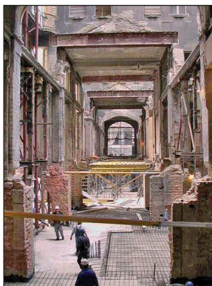
■ 11. kép: A pincefödém kibontása utáni állapot ■ Photo 11. The cellar slab after opening up
