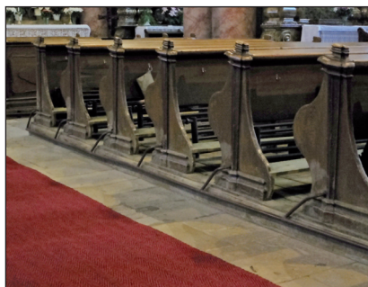
■ 17. kép: A Nagyszeben/Sibiu (Szeben megye) központjában levő római katolikus templom meleg vizes padfűtése és egy a mellékoltárokból elhelyezett fűtőtestek közül. ■ Photo 17. Hot-water operated pew heating in the Catholic church of downtown Sibiu (Sibiu County) and one of the radiators placed in the side altars.
