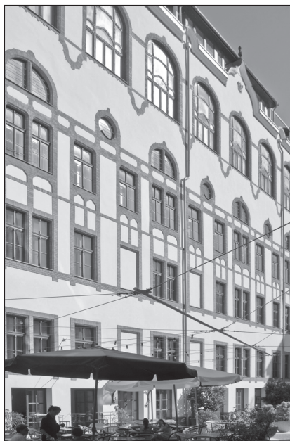
■ Foto 5. A telefonközpont udvari homlokzata a felújítás után
