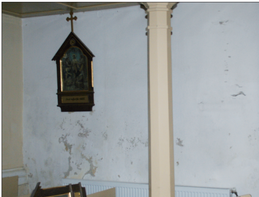
■ 4. kép: Sókivirágzások és pergő festés/vakolat a csíkszentgyörgyi/Ciucsântgiorgiu (Harghita megye) katolikus templom fűtőteste fölött.
