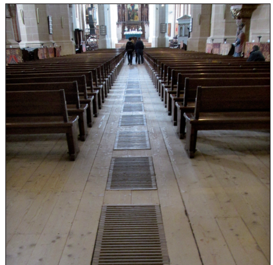
■ 11. kép: A brassói/Braşov (Brassó megye) Fekete templom meleg levegőt befűjő rendszere: a földalatti légcsonna részlete és a templom padlójában levő rácsozat, melyen át a meleg levegő a templomtérbe jut. (Fotó © Brassói szász evangélikus egyházközség)
