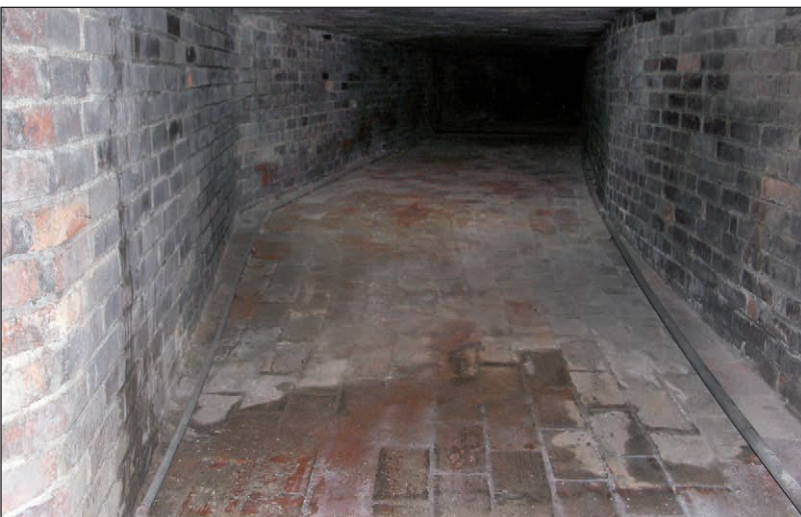
■ 11. kép: A brassói/Braşov (Brassó megye) Fekete templom meleg levegőt befűjő rendszere: a földalatti légcsonna részlete és a templom padlójában levő rácsozat, melyen át a meleg levegő a templomtérbe jut. (Fotó © Brassói szász evangélikus egyházközség)
