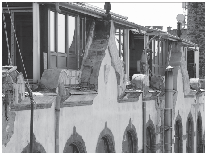
■ Foto 10. A tetőszinti lakások kialakítása ■ Photo 10. Building apartments at the loft level
