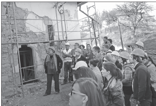
■ 4. kép: A széki református templom felújításának ismertetése (Fotó © UTILITAS)
