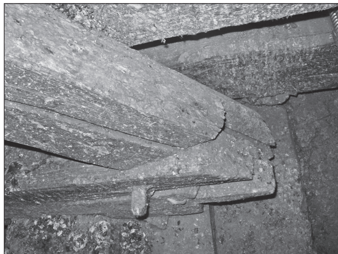
■ Foto 8. Tehnologii de excepție la subansambluri de structură portantă istorică: șarpanta Bisericii Evanghelice din Piața Huet din Sibiu cu câteva noduri coardă-căprior teșite
