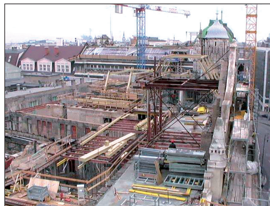
■ 12. kép: A tető építése ■ Photo 12. Construction of the roof
