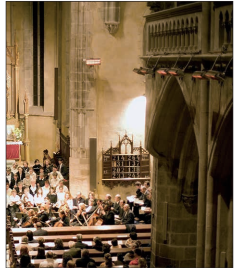
■ 13. kép: A nagyszzebeni/Sibiu (Szeben megye) evangélikus főtemplomba 2006-ban beszerelt gázüzemeltetésű IR hőszugárcső. (Fotó © Nagyszzebeni evangélikus egyházközség)
