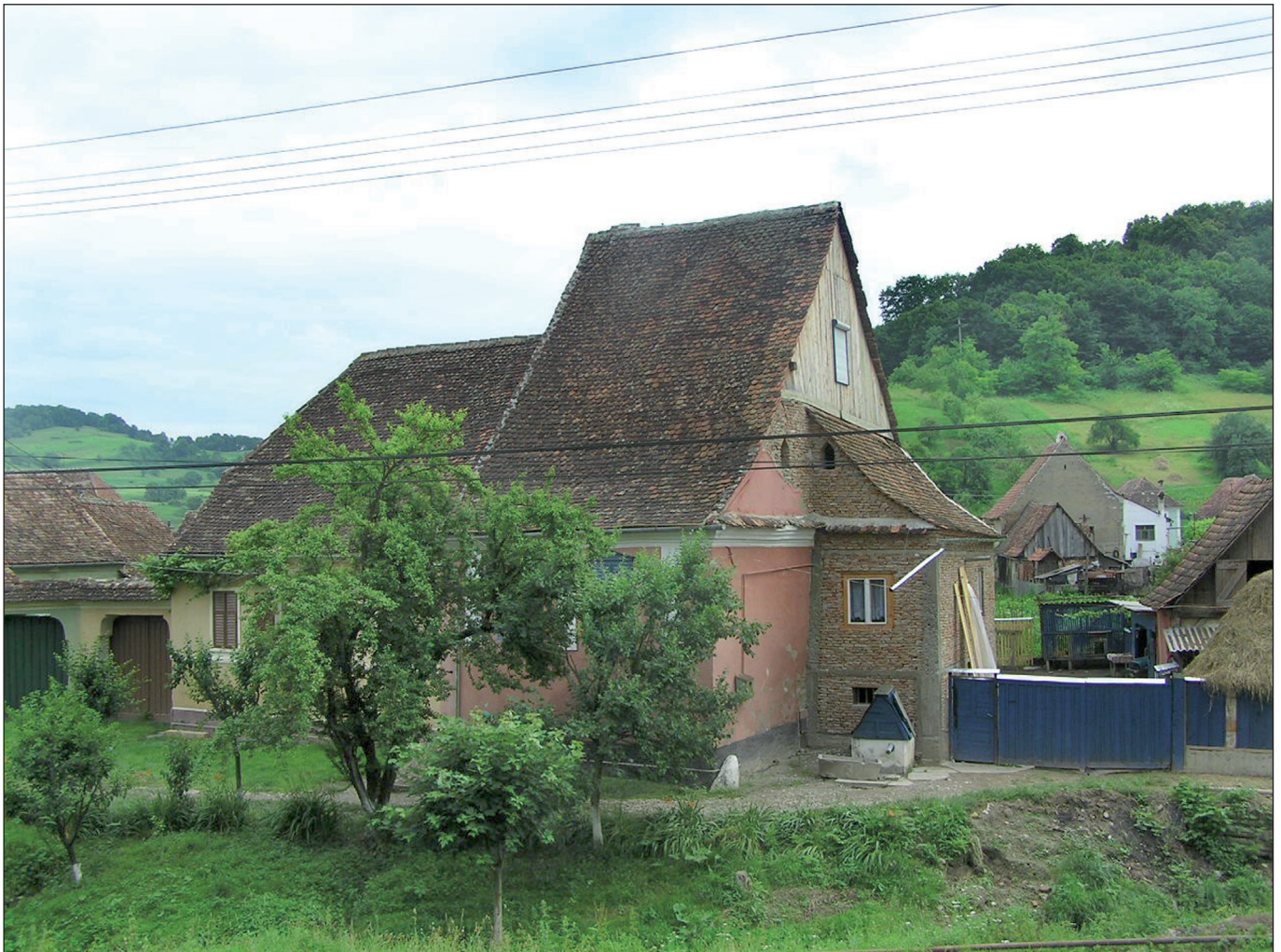
■ 7. kép: Hozzáépítés történeti épülethez, megváltoztatva annak tömegét és nyílászáróit ■ Photo 7. Addition to a historic building, altering its volume and openings
