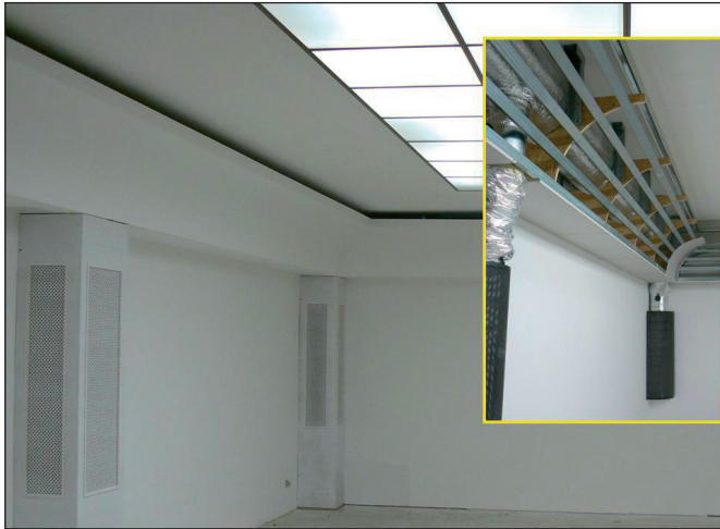
■ 8. kép: A légtechnika elrejtése ■ Photo 8. Concealing air conditioning technique
