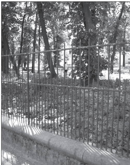
■ Foto 4. Detaliu al împrejurii parcului, pe laturile sudică și estică (soclu din piatră și panouri din fier forjat) (2013). © Andreea MILEA ■ Photo 4. Detail of the park's enclosure, on the southern and eastern sides (stone pedestal and wrought iron panels) (2013). © Andreea MILEA
