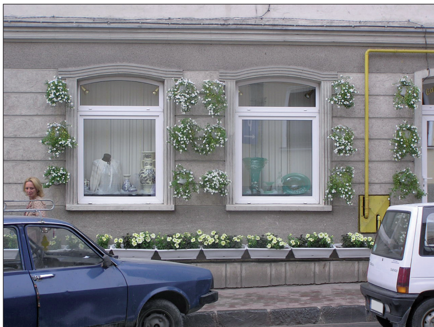
■ 12. kép: Sárga gázvezeték és kicserélt ablakok – magasabb komfort, kisebb történelmi érték ■ Photo 12. Yellow gas pipe and replaced windows – increased comfort, decreased historic value
