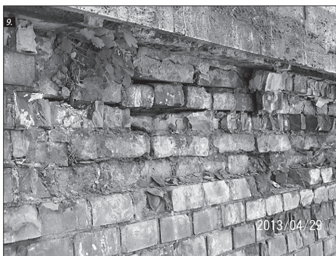
■ 6. kép: Virágok a falban © BÁNKY László, KIRÁLY Béla ■ 7. kép: Algásodás © BÁNKY László, KIRÁLY Béla ■ 8. kép: Zuzmótelepek © BÁNKY László, KIRÁLY Béla ■ 9. kép: Rétegesen szétfagyott fal ■ Photo 6. Flowers in the wall © BÁNKY László, KIRÁLY Béla ■ Photo 7. Algae © BÁNKY László, KIRÁLY Béla ■ Photo 8. Lichen © BÁNKY László, KIRÁLY Béla ■ Photo 9. The flaked frozen wall
