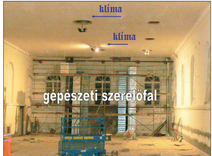
■ 3. kép: Lovarda – légszatórna építés közben ■ Photo 3. Riding hall – installation of the air-tube
