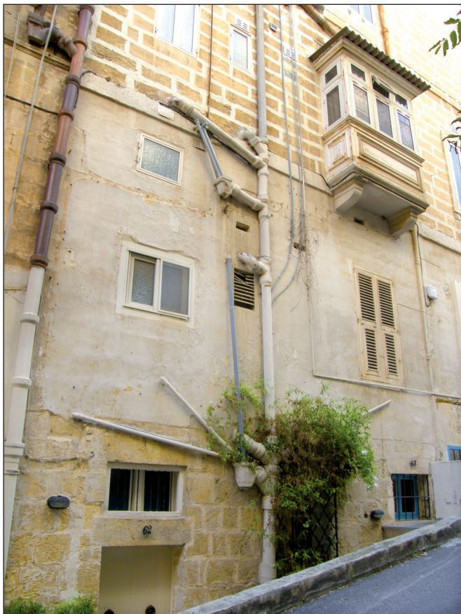
■ 2-3. kép: Csatornavezetés a homlokzaton (máltai példa) ■ Photo 2-3. Drainage on the façade (example from Malta)
