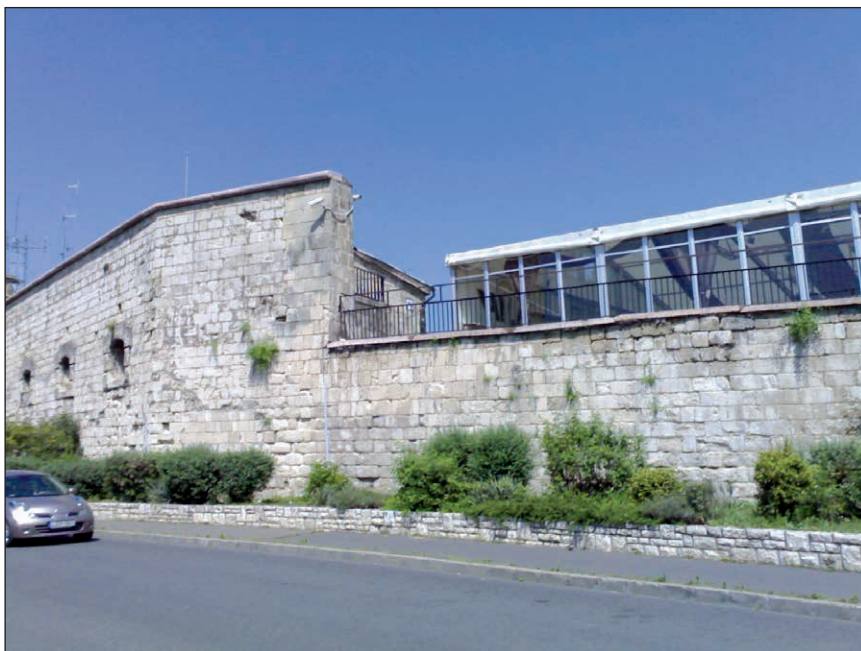
■ 8–9. kép: Ideiglenes épület – engedély nélkül ■ Photo 8-9. Provisional building – without authorization
