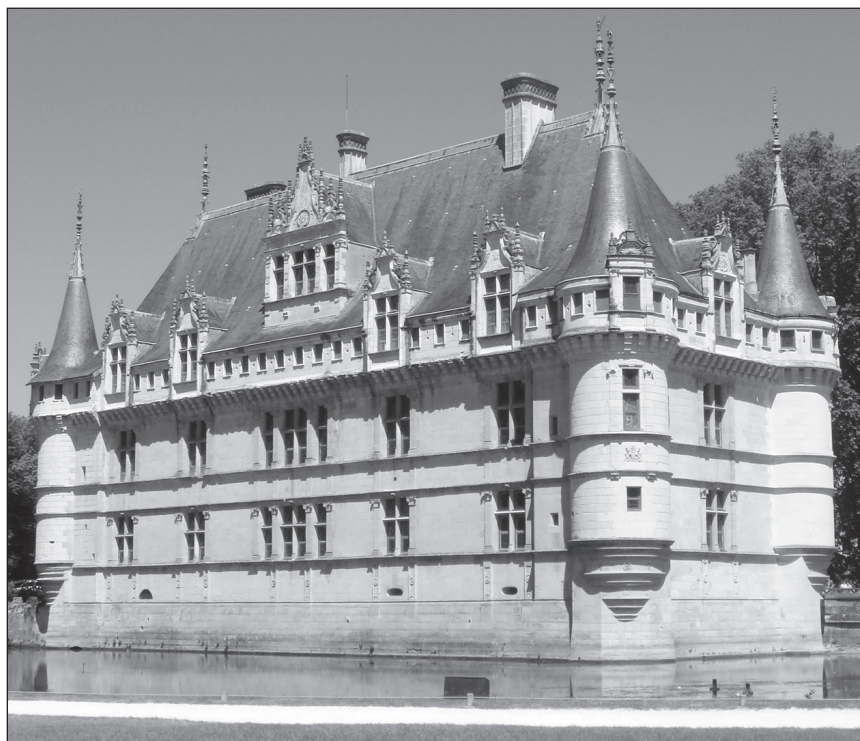
■ Foto 1. „Casa bunicului”: o construcție cu o vechime de câteva secole, bine conformată, făcută cu materiale și manoperă de bună calitate, aflată și astăzi într-o stare bună de conservare evidentă – exterior
