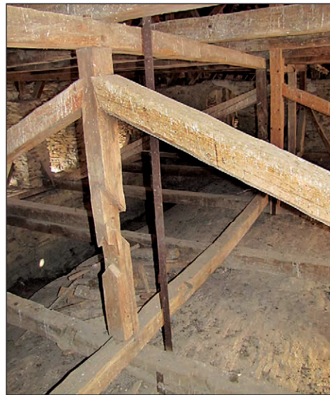
■ 14. kép: Hajó feletti fedélszerkezet, középső székoszlop a védelmi szinten, keletről az 5. állásban ■ Photo 14. The roof structure above the nave, middle post on the defensive level in the 5 th truss from the east
