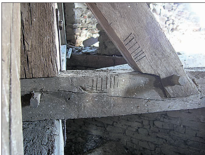
■ 6. kép: Ácsjelek a szentély feletti fedélszerkezetben a középső talpgerendán és könyökfán a védelmi szinten
