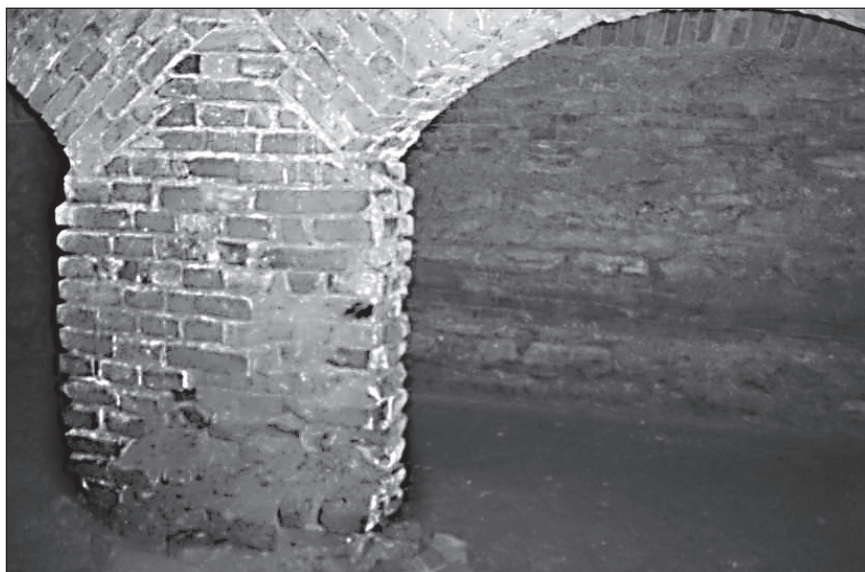
■ 3. kép: Alagsori falazott pillérek rendkívül rossz műszaki állapota [1] ■ Photo 3. Extremely precarious condition of masonry pillars in the basement [1]
