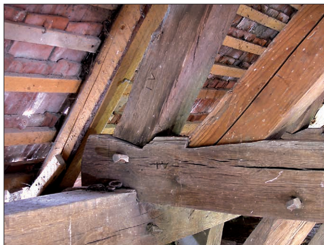
■ 7. kép: Szentély feletti fedélszék, 4. állás, a kötőgerenda és szarufa keleti oldalán látható ácsjelek
