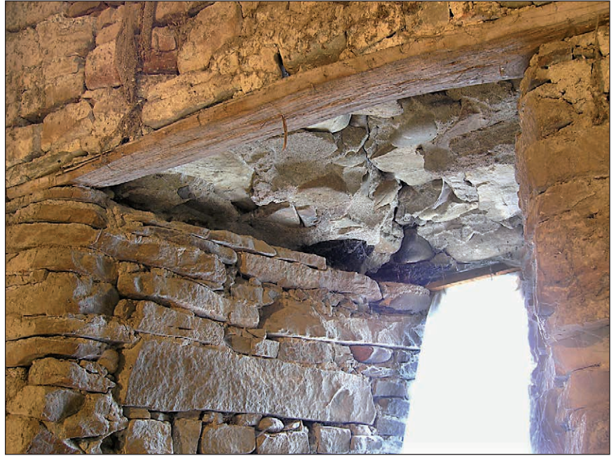
■ 20. kép: A torony 2. emeletén a déli lőrés (2008) ■ Photo 20. Southern loophole on the 2 nd storey of the tower (2008)
