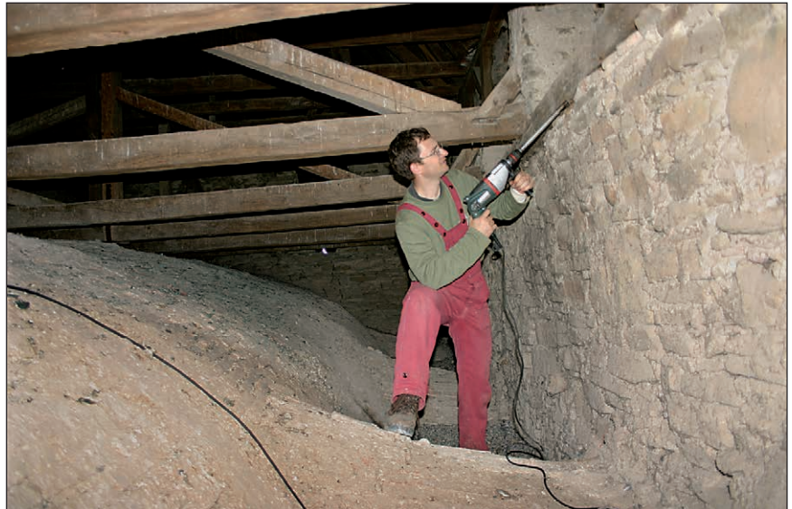
■ 2. kép: Dendrokronológiai furatmintavétel a székelyderzi unitárius templom hajója feletti fedélszerkezetben
