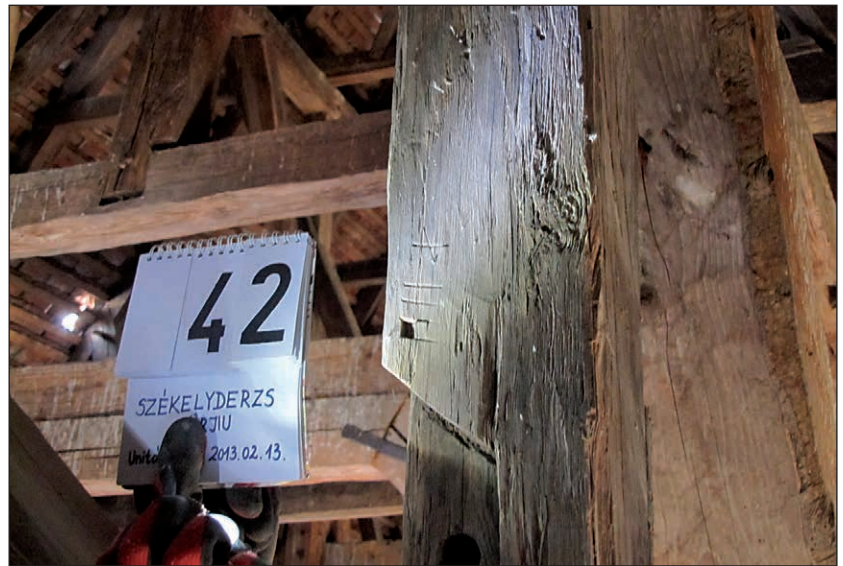
■ 15. kép: Ácsjel a hajó feletti fedélszerkezet eredeti elemén ■ Photo 15. Carpenter mark in the original element of the roof structure above the nave
