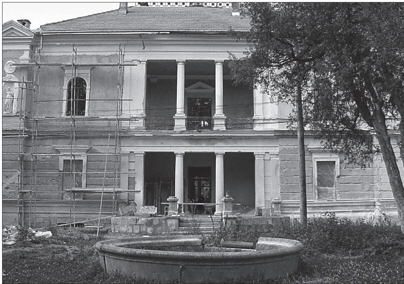
■ Foto 7. Rezalitul central al fațadei nordice, cu cele două loggii suprapuse, terasa semicirculară și micul bazin de piatră ornamentală. (2009) © Andreea MILEA ■ Photo 7. The central projection of the northern elevation, with the two superimposed loggias, the semi-circular terrace and the small ornamental stone basin. (2009) © Andreea MILEA
