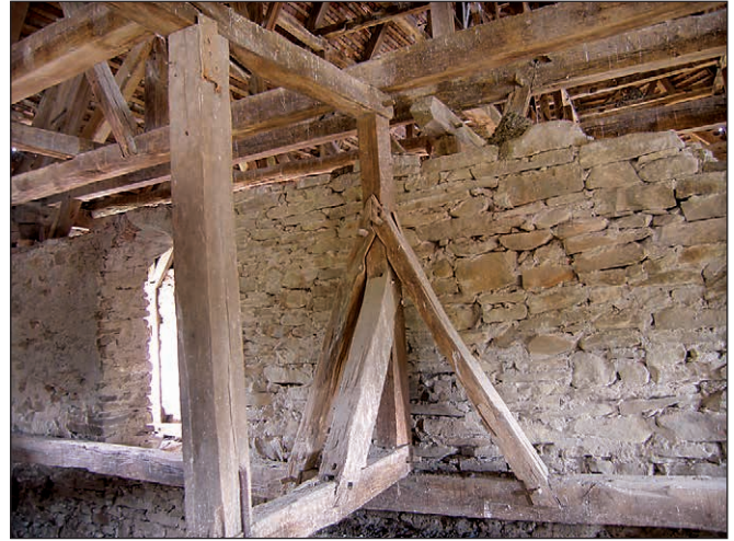
■ 13. kép: Hajó feletti fedélszerkezet, középső székoszlop a védelmi szinten, keletről az első állásban ■ Photo 13. The roof structure above the nave, middle post on the defensive level in the first truss from the east
