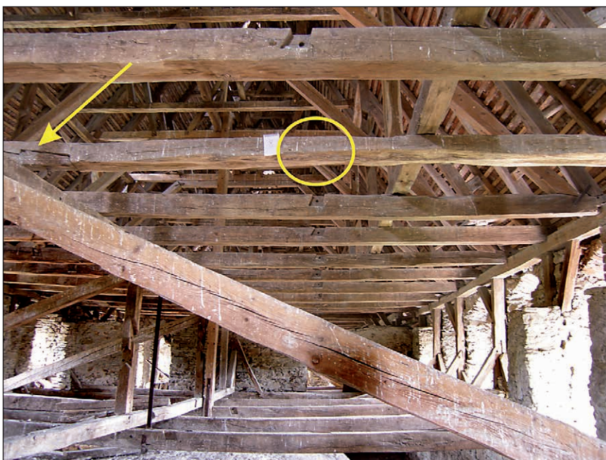
■ 18. kép: Hajó feletti fedélszerkezet, a fedélszék kötőgerendái ■ Photo 18. The roof structure above the nave, tie-beams of the roof
