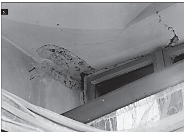
■ 1 a-b. kép: A szászvárosi iskola homlokzati íveinek és boltozatainak károsodása ■ Photo 1 a-b. The decays on the elevation's arches and vaults of the school in Orăștie.
