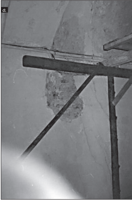
■ 4. ábra: A téglaboltozat beomlásának mechanizmusa ■ Figure 4. The collapsing mechanism of a brick vault
