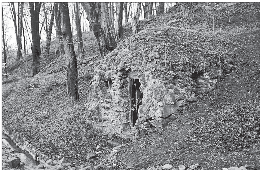
■ 1. kép: Az árkosai (Kovácszna megye) Szentkereszthy-kastélykert Anna-grottája (2008). A terméskőből épült, viszonylag jó állapotban fennmaradt építmény közvetlenül a csatorna mellett található. A kommunizmus évtizedei alatt ajtó és ablakkerettel látták el, s új funkciót (kazánház) helyeztek el benne © FEKETE Albert
