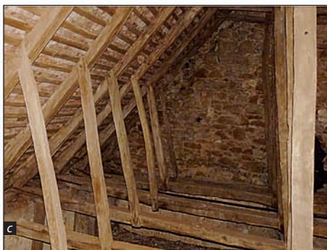
■ Foto 4 a-c. Intervenții ulterioare – șarpanta navei principale, Biserica Evanghelică din Vurpăr ■ Photo 4 a-c. Subsequent interventions – main nave roof structure, the Lutheran church in Vurpăr
