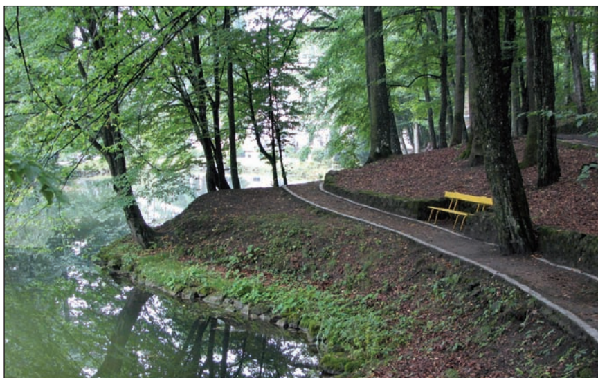
■ Foto 10. Aleea de țarm a lacului, cu zid de sprijin din piatră spre versant și retrageri alveolare pentru bănci, 2009 © Andreea MILEA ■ Photo 10. The lake's shore walkway, with a stone support wall towards the slope and semicircular recesses for benches, 2009 © Andreea MILEA
