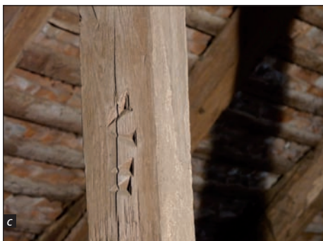
■ Foto 7 a-c. Semne de asamblare – șarpanta navei principale, Biserica Evanghelică din Toarcla ■ Photo 7 a-c. Assembly marks – main nave roof structure, the Lutheran church in Toarcla
