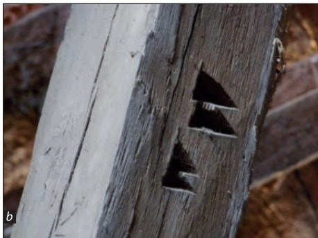
■ Foto 8. Semn de transport – șarpanta navei principale, Biserica Evanghelică din Toarcla ■ Photo 8. Transportation marks – main nave roof structure, the Lutheran church in Toarcla
