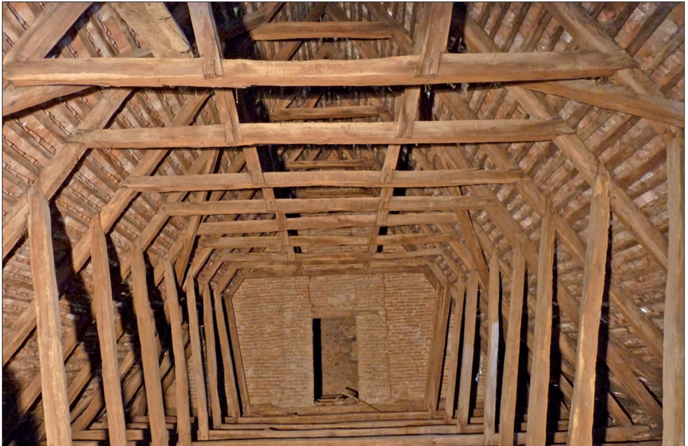
■ Foto 6. Subansamblu de șarpantă al navei principale, Biserica Evanghelică din Toarcla ■ Photo 6. Main nave roof structure sub-unit, the Lutheran church in Toarcla
