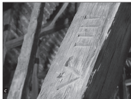
■ Foto 3 a-c. Semne de asamblare – șarpanta navei principale, Biserica Evanghelică din Vurpăr
