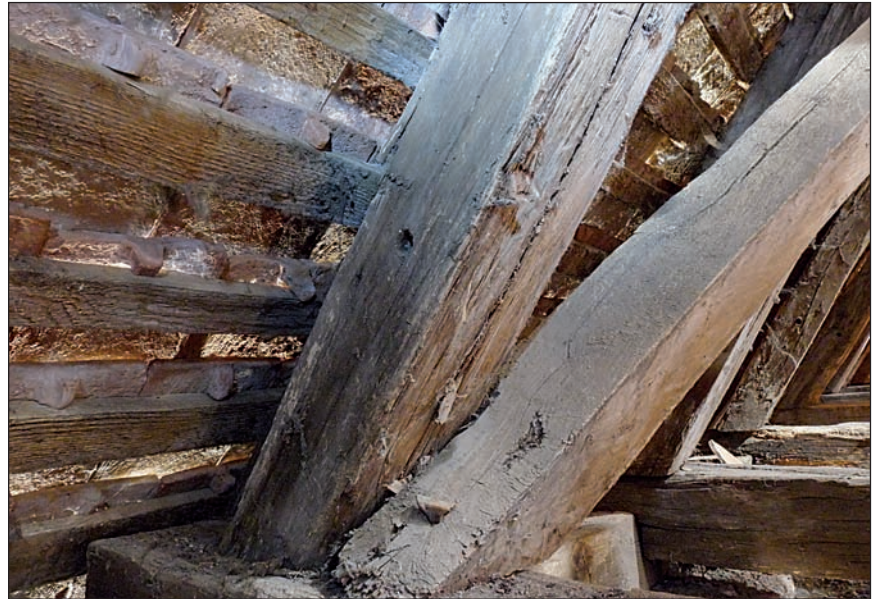
■ Foto 8. Semn de transport – șarpanta navei principale, Biserica Evanghelică din Toarcla ■ Photo 8. Transportation marks – main nave roof structure, the Lutheran church in Toarcla
