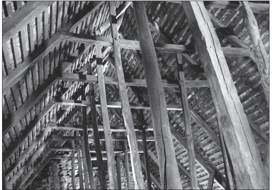
■ Foto 2. Subansamblu de șarpantă al navei principale, Biserica Evanghelică din Vurpăr ■ Photo 2. Main nave roof structure sub-unit, the Lutheran church in Vurpăr
