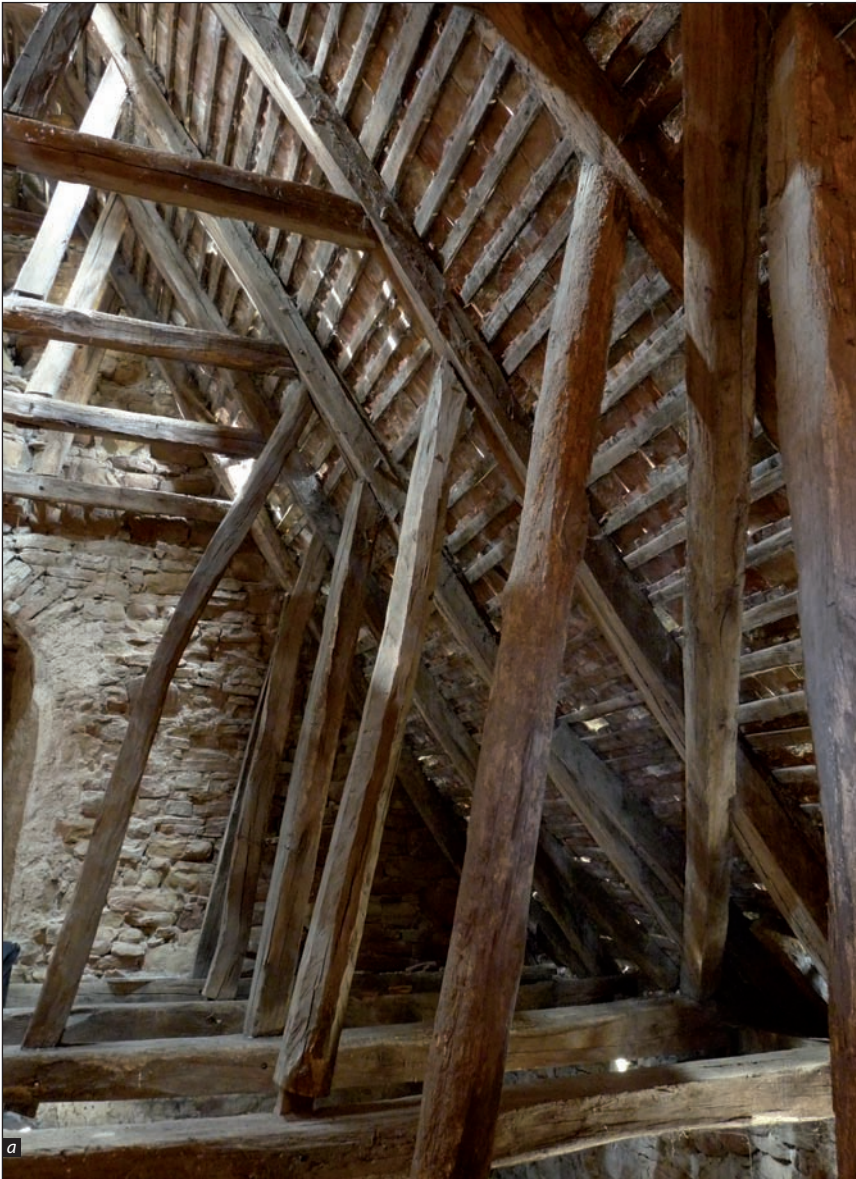
■ Foto 10 a-c. Intervenții ulterioare – șarpanta navei principale, Biserica Evanghelică din Toarcla ■ Photo 10 a-c. Later interventions – main nave roof structure, the Lutheran church in Toarcla
