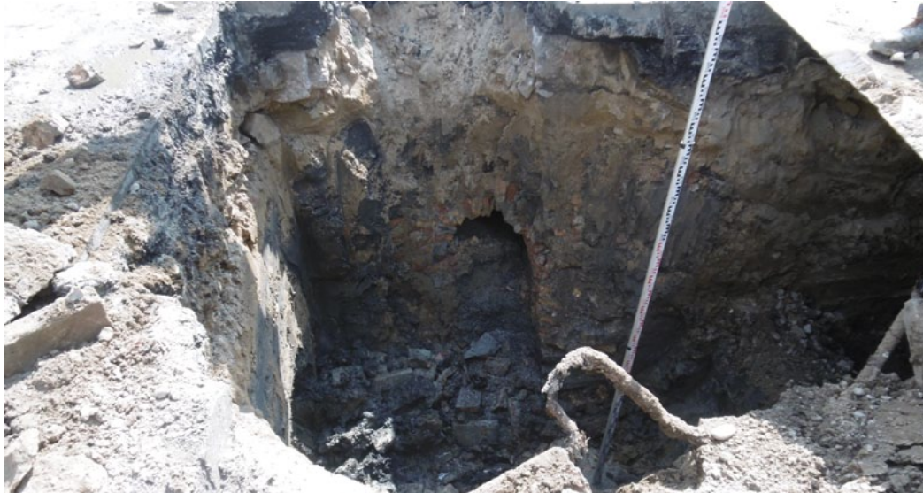
3. kép: Az egykori Hód-tó iszapos medrébe ástott, újkori, boltíves téglacsatorna átvágása az Ady Endre utca és a Tóalj utca kereszteződésében 2018-ban. TJM Fotótár ltsz.: 5605.
