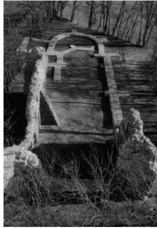
1. kép: A csomorkányi templom még álló falmaradványai és a feltárt alapok az állagmegóvást követően.
