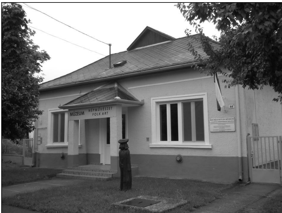
Új nyílászárók a népművészeti kiállítás épületén (Bocskai u. 21.)
