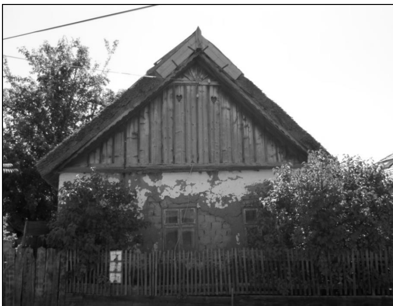
12. kép: Kettős tagolású, napsugaras-állóhézagos deszkaoromzatú nádtető ház. Az oromzat szélein díszes szél-deszkák, csúcsán deszka csúcsdísz. Fehér utca (fotó: Sándor Eszter)
