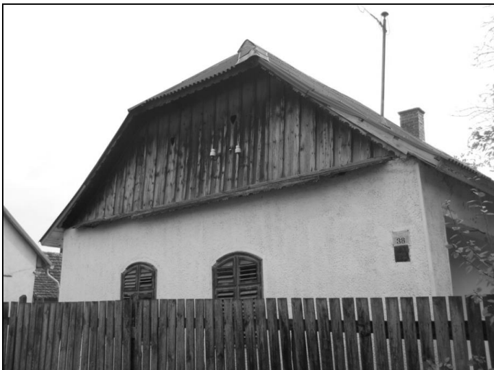
10. kép: Állóhézagos deszkaoromzat félkontyos tetős házon. Az oromzat szélein díszes szegélydeszkák. Hajdú utca (fotó: Sándor Eszter)
