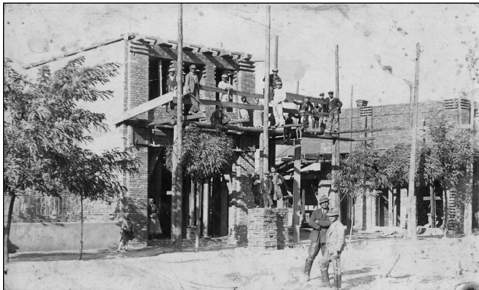
Cukrászda építése a 30-as években 38
