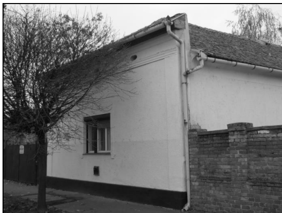
2. kép: Oldalhomlokzatossá alakított véghomlokzatos ház, felül a polgárházakra jellemző szellőzőnyílásokkal. Rákóczi utca (fotó: Sándor Eszter)
