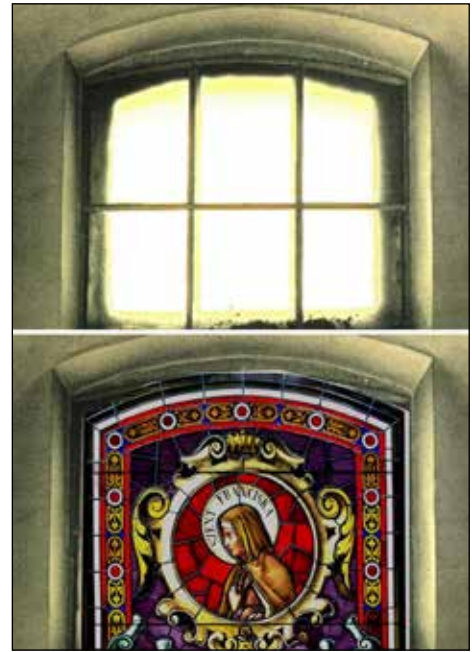
■ 12. kép. Újhartyán (Magyarország): felül a római katolikus templom ablaka a helyreállítás előtt, alul a restaurált, festett-ólmozott ablak behelyezése után © MÁTÉ Zsolt ■ Photo 12. Újhartyán (Hungary): above, the window of the Roman Catholic Church before conservation; below, the conserved, stained-glass window © Zsolt MÁTÉ
