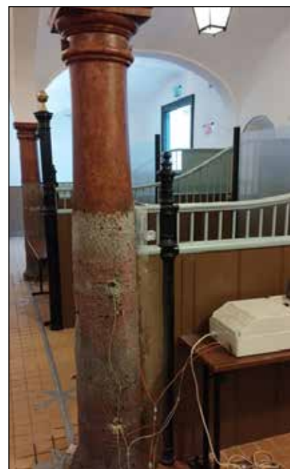
■ 6. kép. A gödöllői kastély istállója, a fenti képen látjuk, hogy a só ledobja a műmárvány burkolatot; a lenti kép mutatja a sótalánítást © MÁTÉ Zsolt
