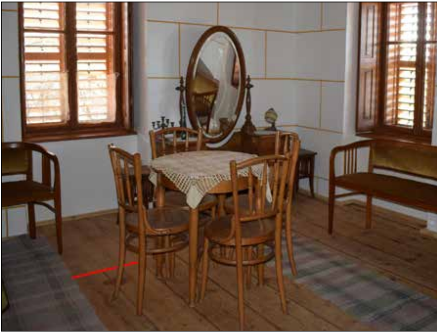
■ 11. kép. Padlókiegészítés Galošpetriben (Románia): a piros vonal feletti rész betoldás hasonló korú épület padlójából © MÁTÉ Zsolt ■ Photo 11. Floor addition in Galošpetreu (Romania): the part above the red line is an insertion from the floor of a building of similar age © Zsolt MÁTÉ
