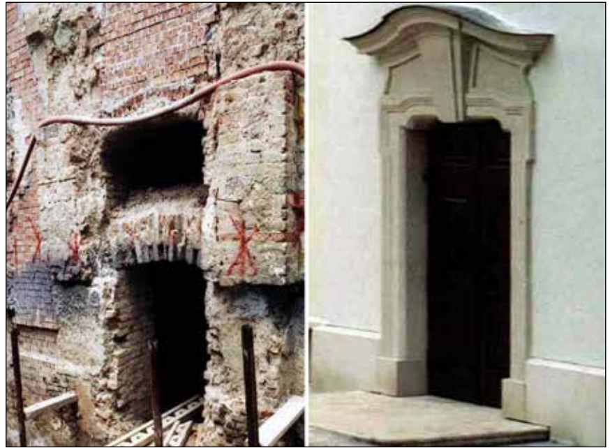
■ 9. kép. Barokk színház bejárata a gödöllői kastélyban, felújítás előtt és után © MÁTÉ Zsolt ■ Photo 9. The entrance to the Baroque Theatre in the Gödöllő Palace, before and after conservation © Zsolt MÁTÉ
